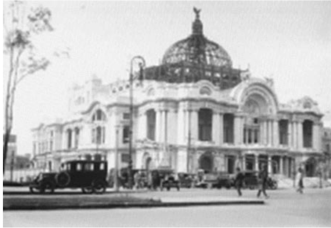
(Foto 33) Anónimo, Palacio de Bellas Artes en construcción , México 1910, Técnica: Plata gelatina. Formato: 12.7 - 17.8 cm, SINAFO. Núm. de Inv. 84955.
