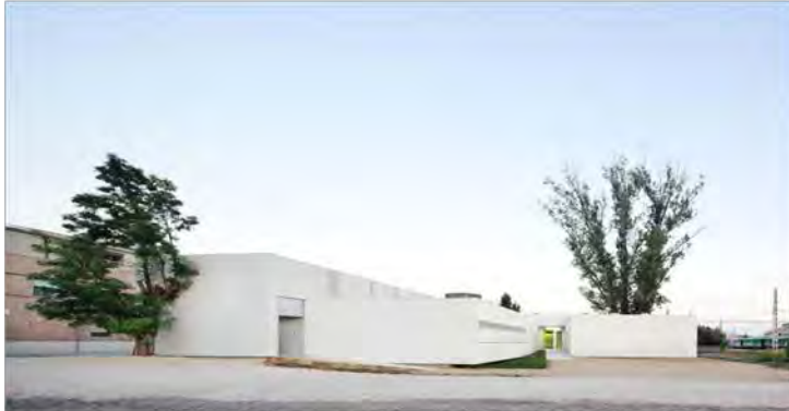
FACHADA DE ACCESO
