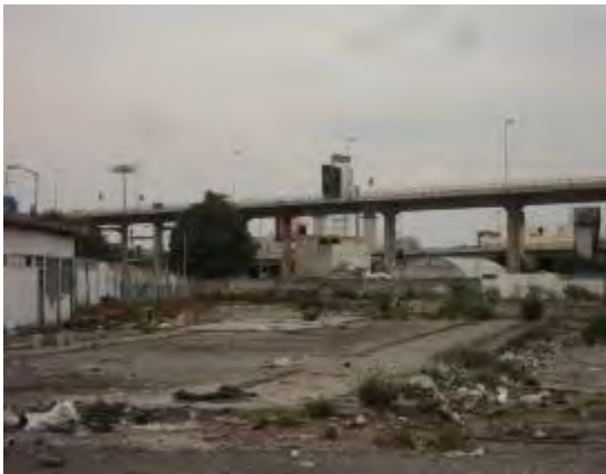
VISTA HACIA PUENTE 2DO NIVEL PERIFÉRICO
