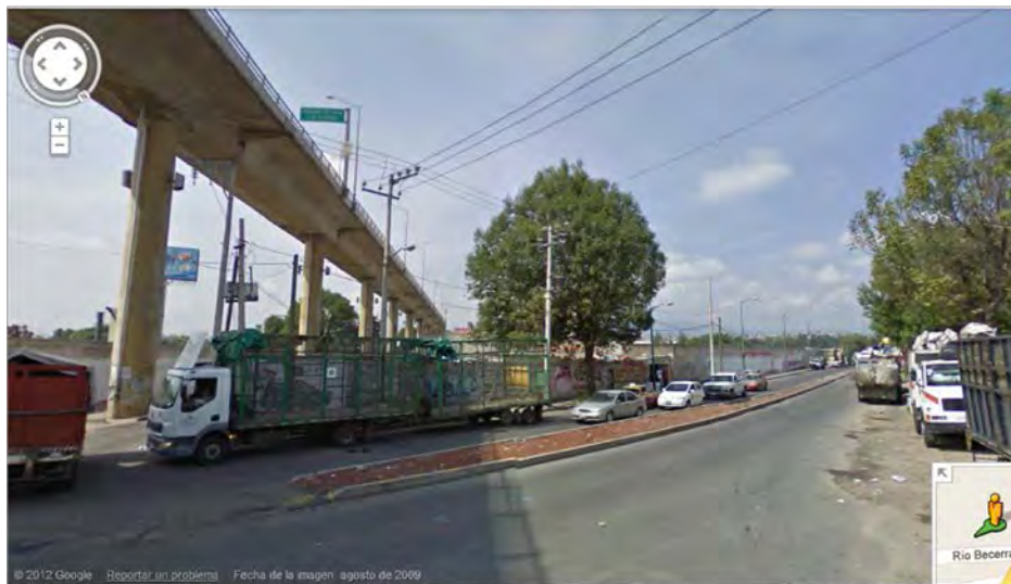
VISTA DEBAJO DE PUENTE 2DO NIVEL
