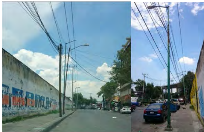
LUMINARIAS DE LA ZONA
