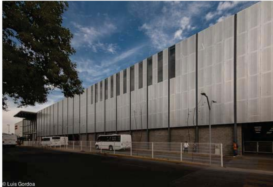
Fachada principal CETRAM “el rosario”.
