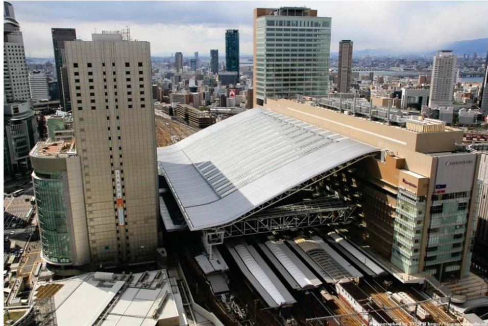
Conjunto de estación de transferencia en Osaka, Japón.
