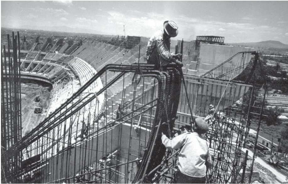
Construcción de Columnas Estadio Azteca
