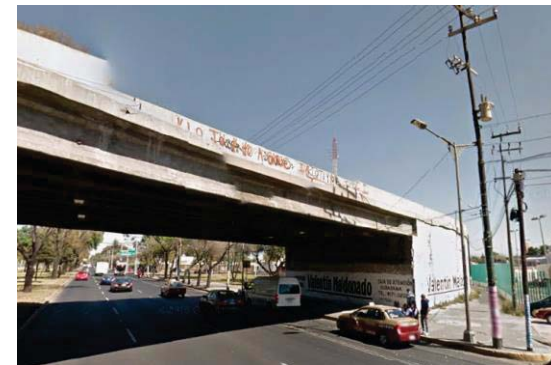
Imagen 6. Vista desde Calzada de Tlalpan al norte
