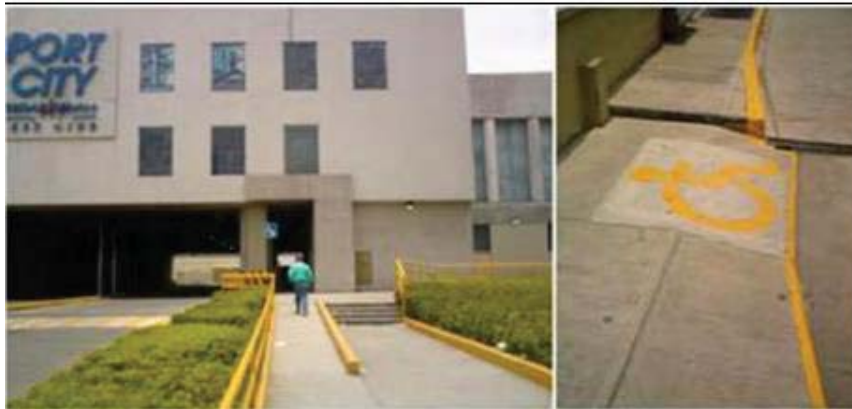
Accesibilidad rampa acceso al CETRAM, a la izq. No permite la circulación de sillas de ruedas.
