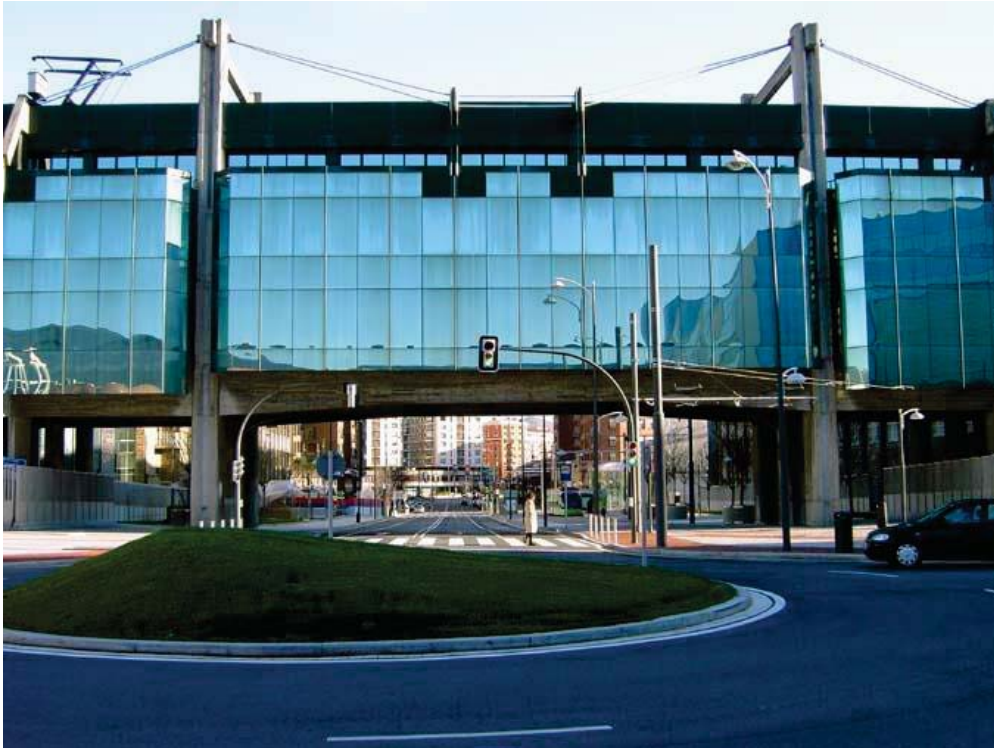
La prolongación de la avenida del ferrocarril sobre la intermodal
