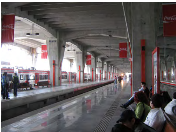
Imagen 35. Andenes de la Estación Buenavista, Tren Suburbano 2015.
