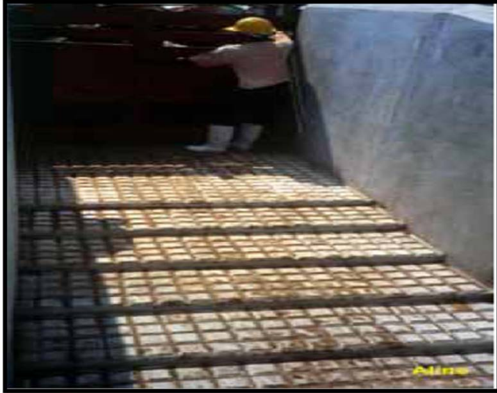
Imagen 4. Rampa de concreto con escalones.
