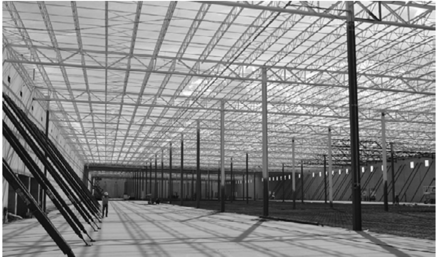
Imagen: Portafolio Armadura Pratt - STEELYAR
