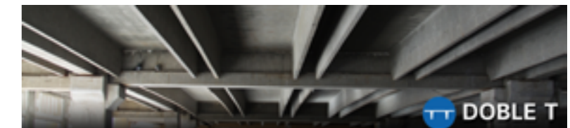
Imagen: Losa Doble TT, Trabis.com
