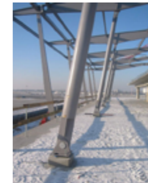
Imagen: Columnas Articuladas Aeropuerto Internacional de Varsovia
