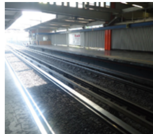
Vías del metro, estación Taxqueña. Fotografía de: Fabián Pérez.2015
