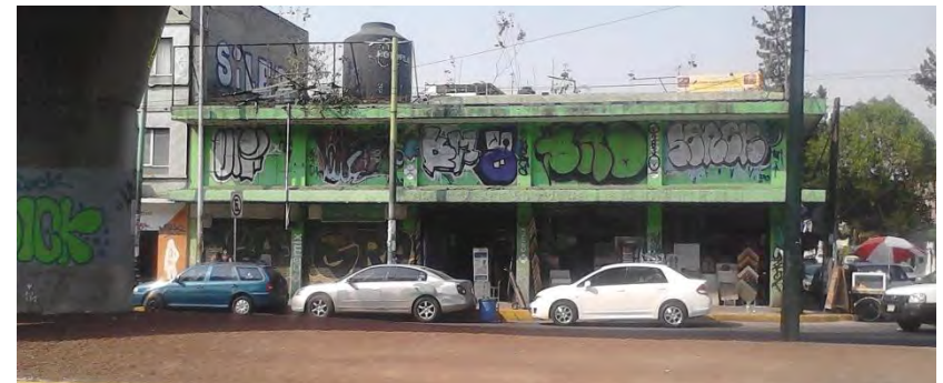
Contaminación visual por vandalismo sobre Calzada Ermita Iztapalapa
