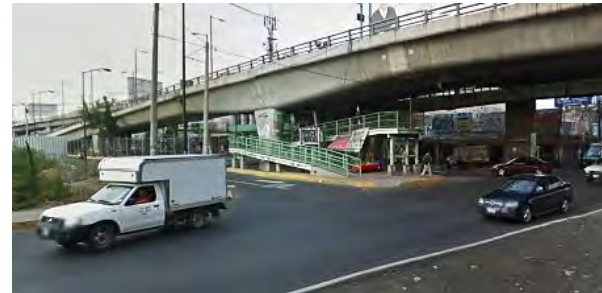
Vista bajopuente de la intersección de Calzada Ermita Iztapalapa y Eje 3 Oriente.
