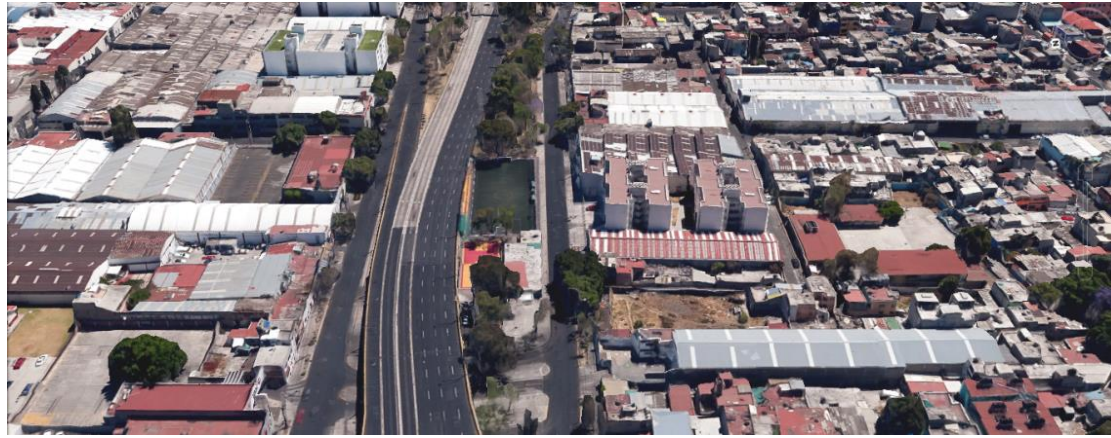
Vista 4. Parte lateral izq. del predio. Vista aérea.
