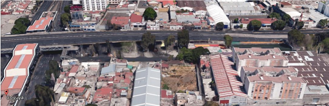
Vista 2. Parte trasera del predio. Vista aérea.
