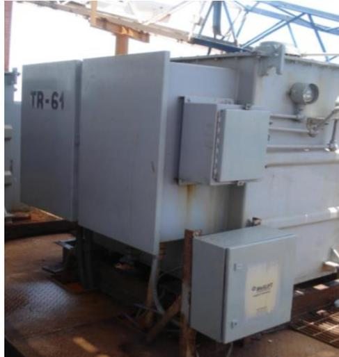
Fig. 2.2.2 Transformador elevador
