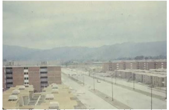
Fotografía 6) Primera imagen del conjunto terminado para las olimpiadas.
