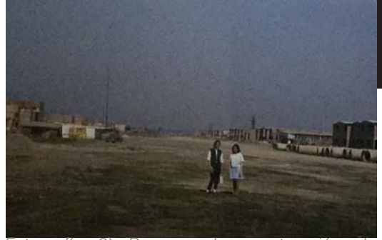
Fotografía 3) Proceso de construcción de viviendas en la U.H. Narciso Mendoza.
