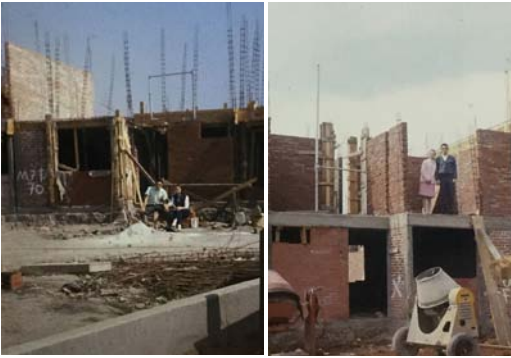
Fotografías 4-5) Proceso de construcción de viviendas en la U.H. Narciso Mendoza.
