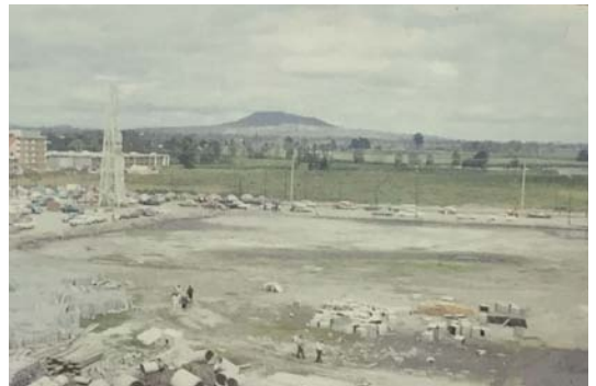
Fotografía 1) Así lucían los terrenos de la Hacienda de Coapa al iniciar las obras de construcción de la Unidad Habitacional.
