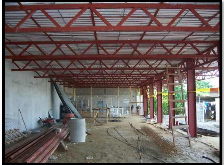
Figura 3.3 Vigas compuestas por un sistema a base de armadura.
