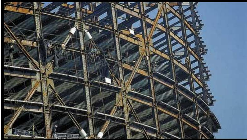
Figura 1.19. Contraventeo de edificios.
