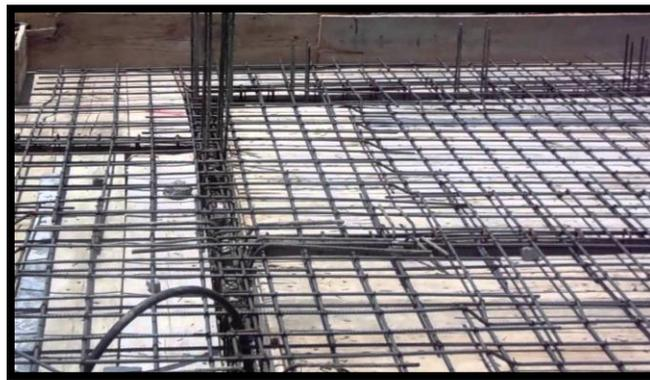
Figura 3.1. Armado de losa maciza de concreto reforzado.
