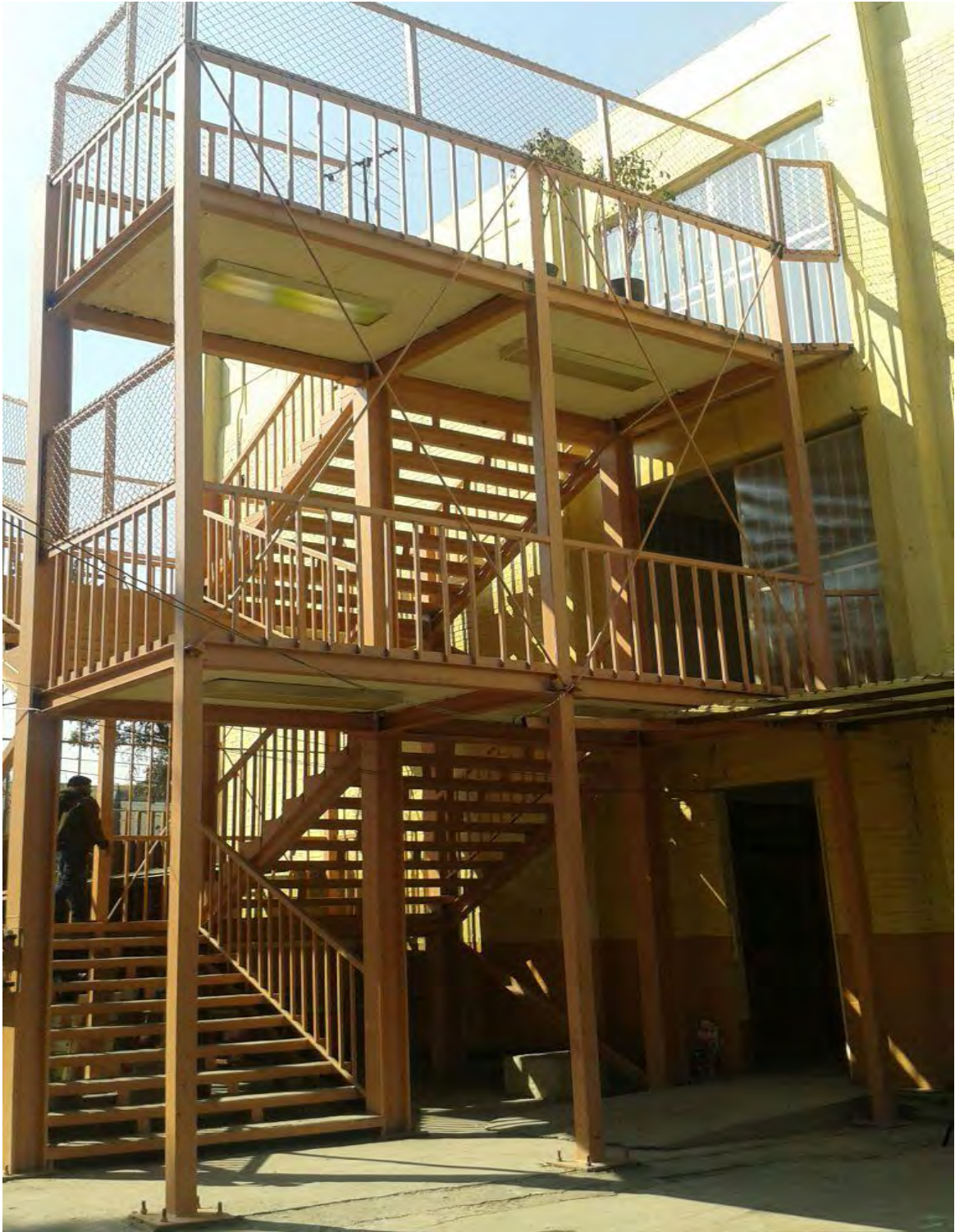
Escalera de emergencia oriente
