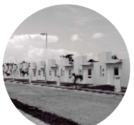
Imagen 5. Fachadas homogéneas en un conjunto de vivienda social en Mérida.
