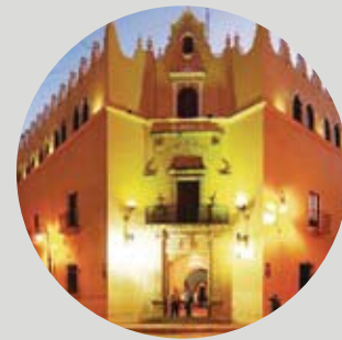
Imagen 11. Edificio de San Francisco Javier (UADY)
