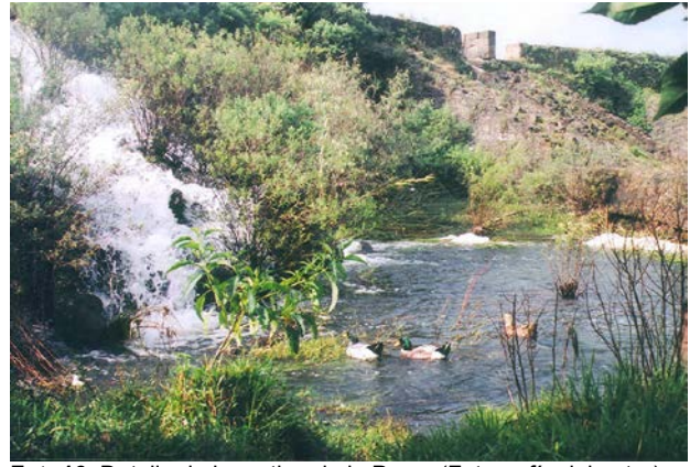
Foto16. Detalle de la cortina de la Presa (Fotografía del autor).
