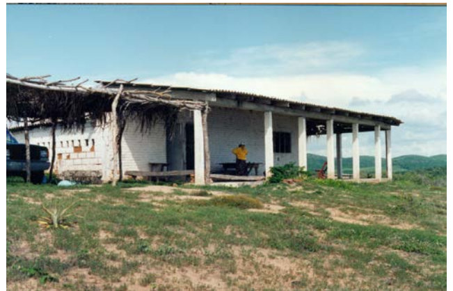
Foto 2. Casa Ejidal. Antes de ser demolida para la construcción de “El Cielito” (Fotografía de Allan Ortega Muñoz 2001).
