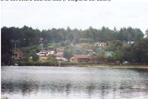
Foto 19. Panorámica vista desde el sureste (Fotografía del autor).
