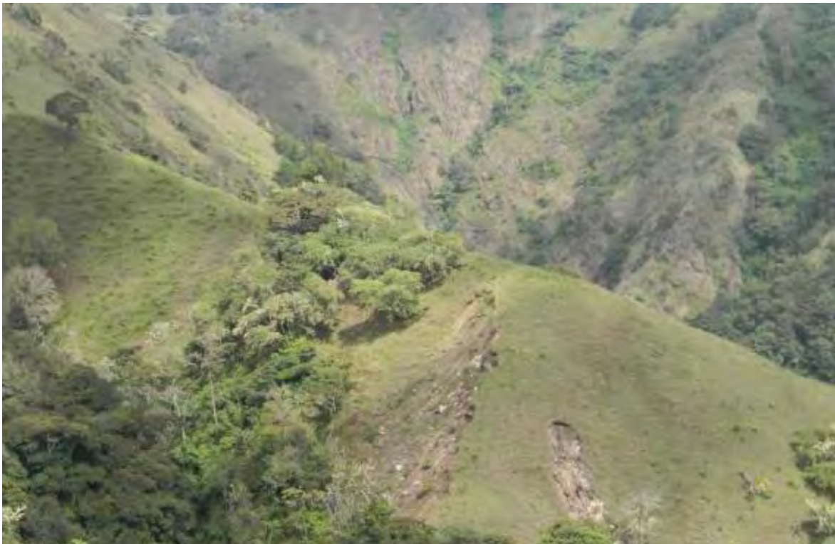
Figura 39. Caídas en la cabecera del río Buenavista, al norte del poblado de Playas (Diciembre, 2012).
