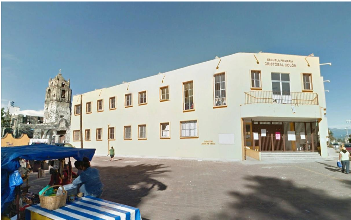
Imagen 47. Nueva Primaria Cristóbal Colón inaugurada en 2013, sustituyó al anterior edificio por agrietamientos y hundimientos. Google Earth, Street view 2015.
