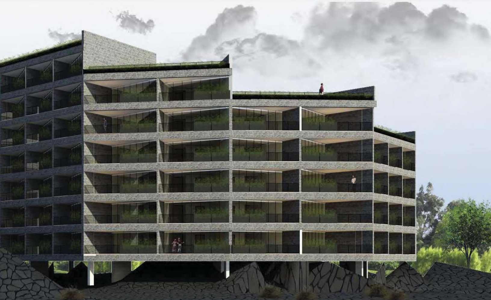
Fachada Principal. Edificio D Vista principal de área habitacional
