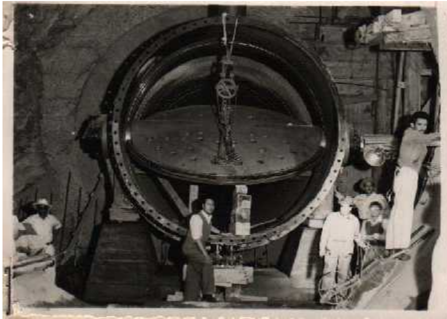
Ilustración 13 válvula de descarga. Fotografía proporcionada por el Ing. Canchola.
