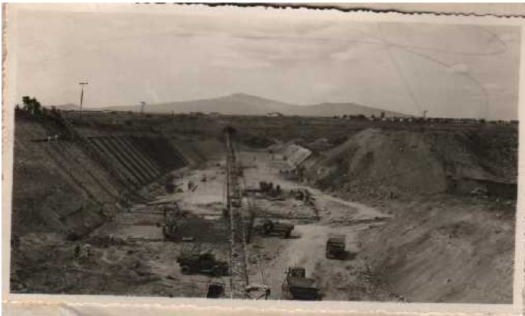
Ilustración 11 construcción de la cortina de la presa Solís. Fotografía proporcionada por Ing. Canchola, Responsable actual de la compuerta de la presa Solís
