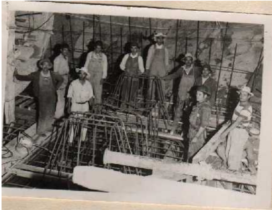
Ilustración 15 interior de la compuerta de la Presa Solís Fotografía extraída del archivo de CONAGUA en las inmediaciones de la compuerta
