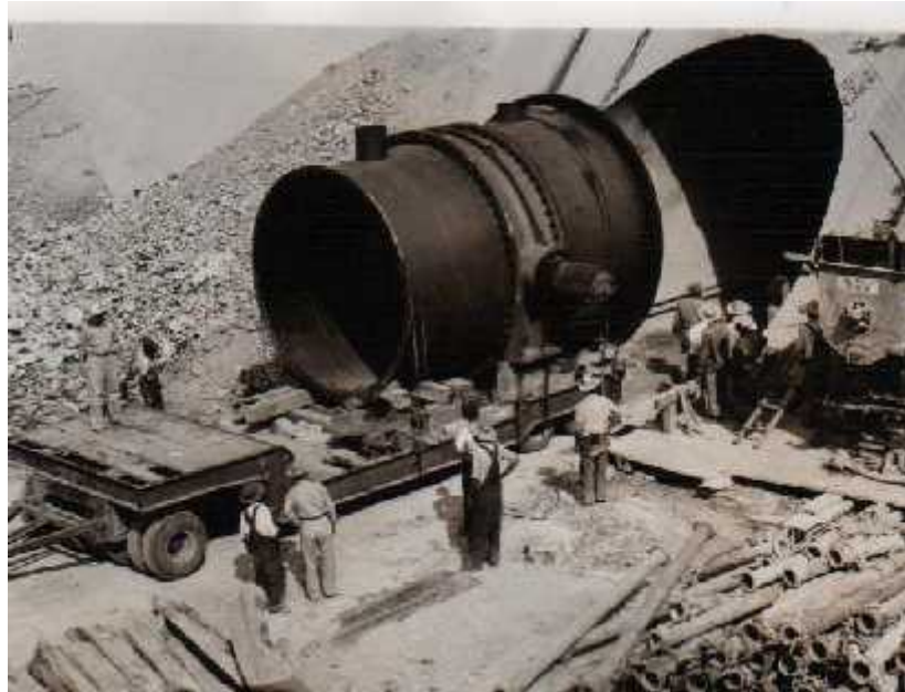
Ilustración 12 una de las dos válvulas de la presa Solís. Fotografía extraída de las oficinas de Conagua en la compuerta de la Presa.
