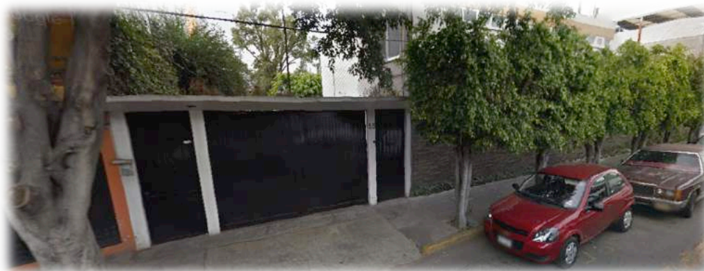
Vista desde calle Árbol de fuego, entrada principal
