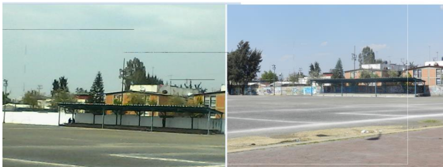
Figura 36 Gradas y bardas perimetrales antes (der) y después (izq) de la intervención
