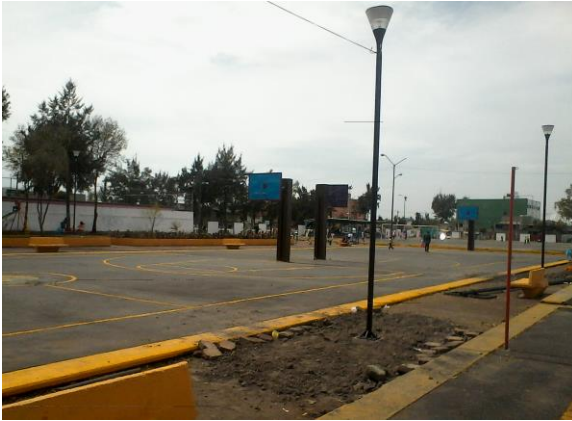
Figura 30. Luminarias tipo "farola"
