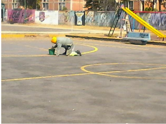
Figura 25. Pintura de canchas
