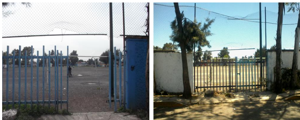
Figura 34. Reparación de acceso calle Cisne
