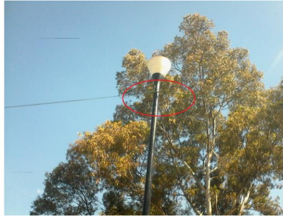
Figura 31. Instalación del cable eléctrico
