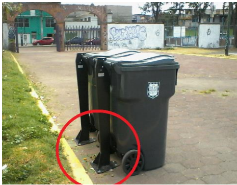
Figura 32. Aseguramiento de contenedor al piso
