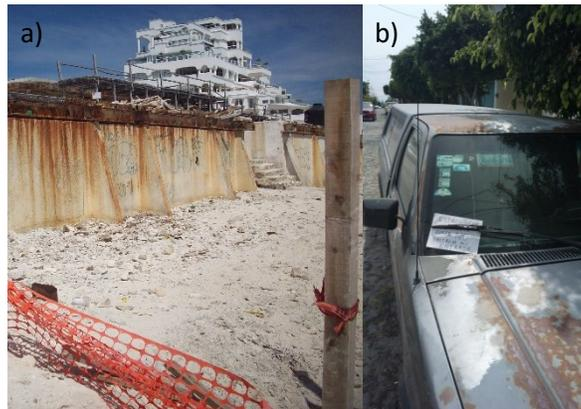
*Ilustración 1-1 Ejemplos fácilmente identificables de corrosión: (a) Estructura metálica deteriorándose en un medio marino (b) Falla de corrosión en recubrimientos.*
