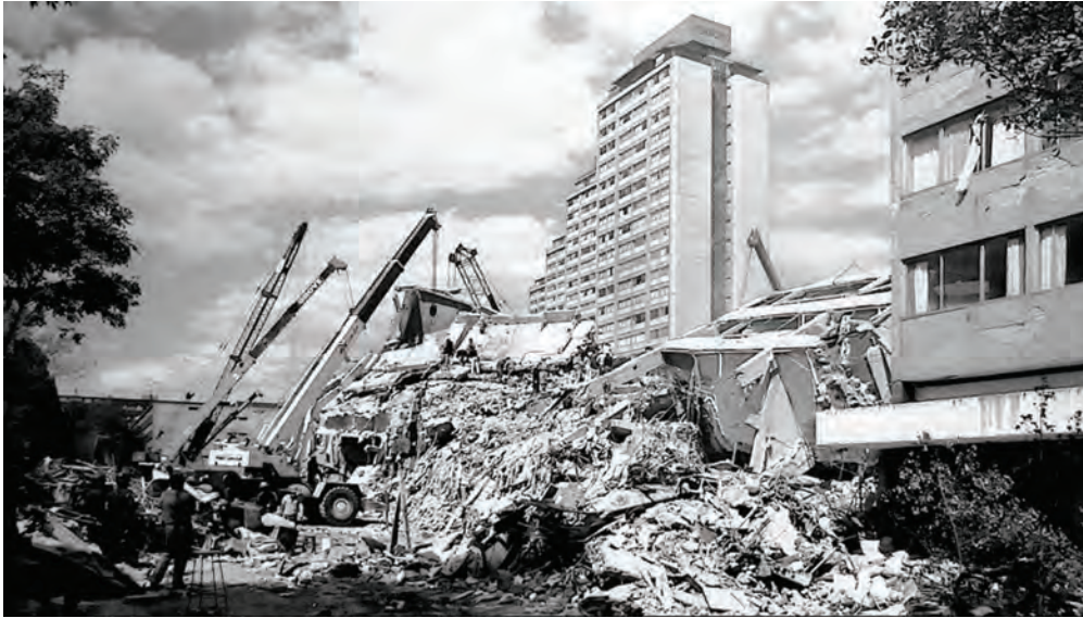
Ilustración 2. Tlatelolco después del terremoto de 1985
