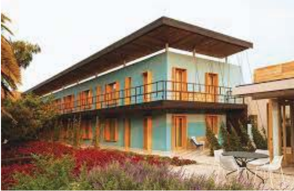
Fig. 66 Patio y edificio de habitaciones del Hotel Boutique Bô.
