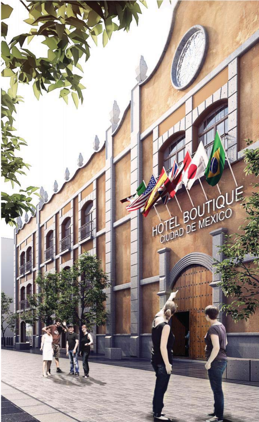
Fig. 71 Fachada principal Hotel Boutique Ciudad de México, Corredor Regina Centro Histórico.
