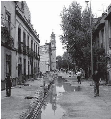
Fig. 45: Calle de Regina antes de ser rehabilitada
