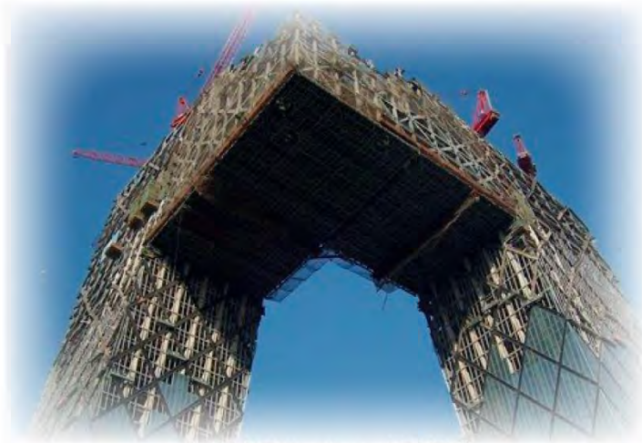
CCTV, Estructura, ARUP 50
