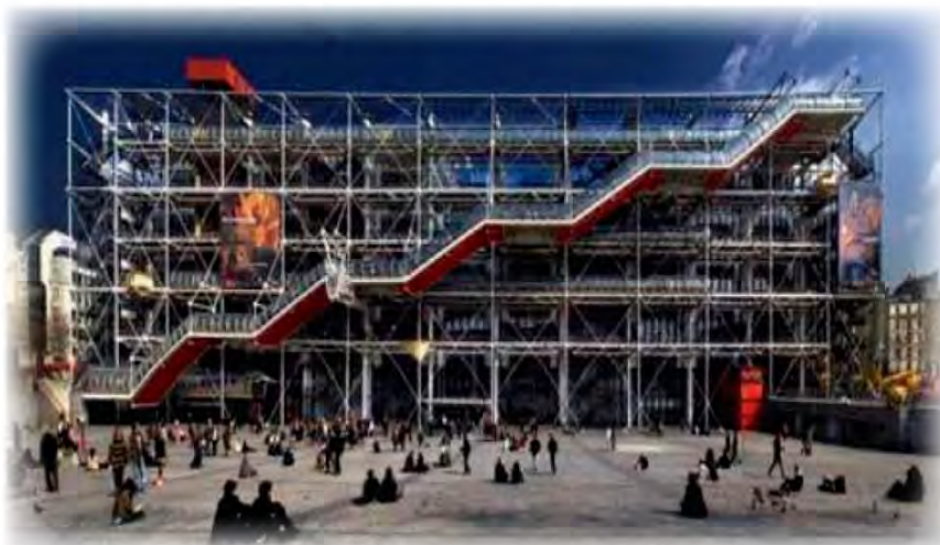
Fachada Centro George Pompidou, Michel Chéron 12
