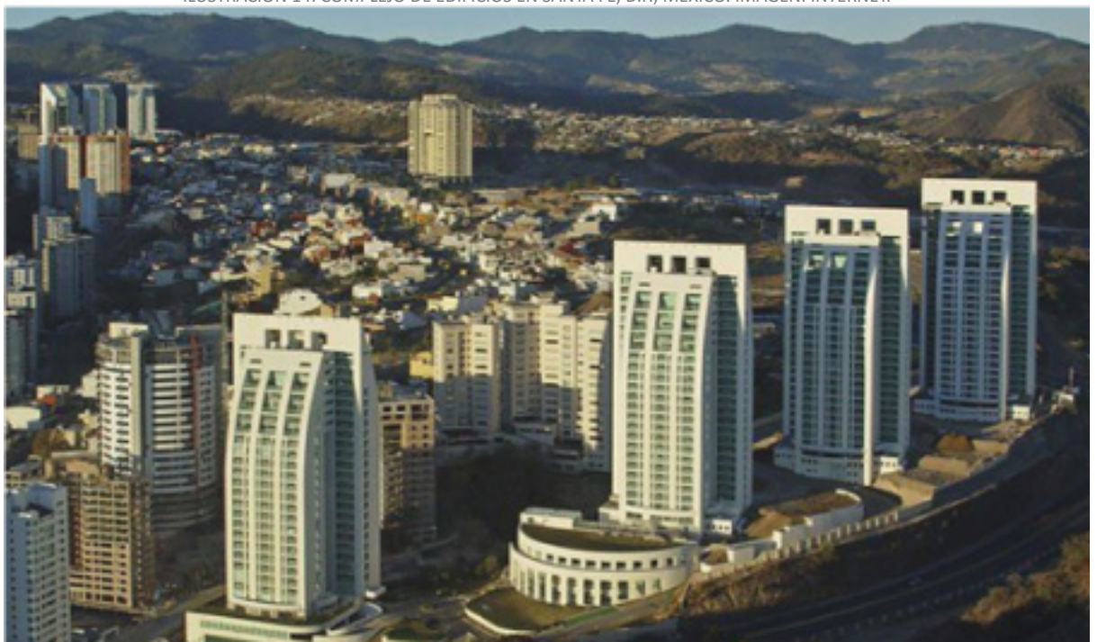
ILUSTRACIÓN 14: COMPLEJO DE EDIFICIOS EN SANTA FE, D.F., MÉXICO. IMAGEN: INTERNET.
