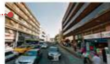
Banqueta insuficiente para el flujo peatonal
