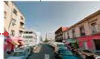
Estacionamiento en la vía pública Invasión de edificio catalogado
