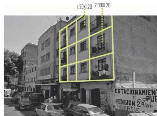
HAY UN EQUILIBRIO ENTRE EL VANO Y EL MACIZO GENERANDO BALCONES, SE LA SIMETRÍA ESTA PRESENTE EN TODA LA FACHADA
