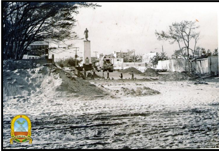
Figura 4. Arranque de obra de la primera etapa del malecón.
