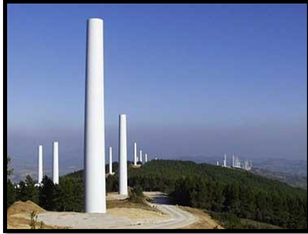
Figura 24. Imagen de aerogeneradores tubulares.
