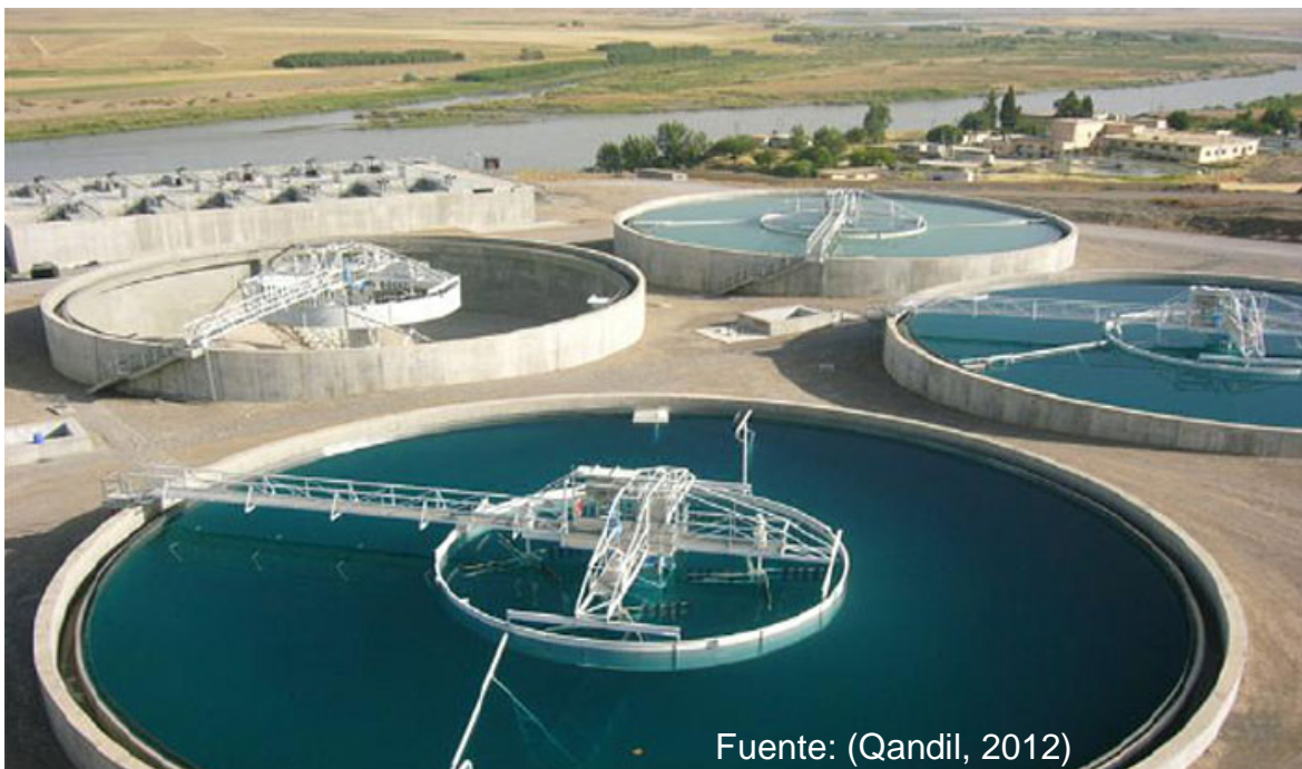
Figura 6. Clarificador convencional
