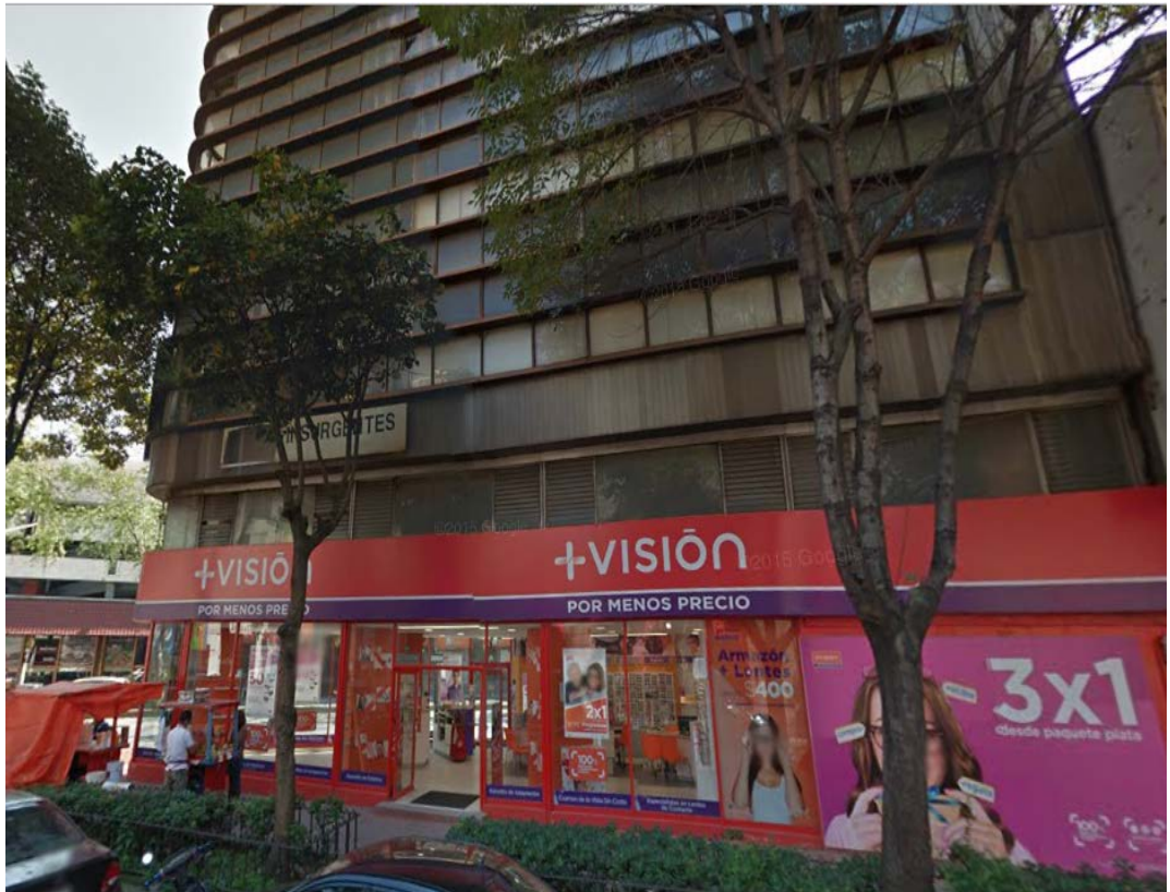
4. Insurgentes esq. Londres, presenta comercio en planta baja activos, y los niveles superiores en abandono.
