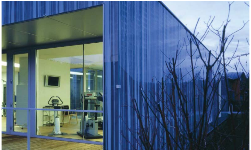
99. Acabados Exteriores, policarbonato (Centro de fisioterapia y rehabilitación)
