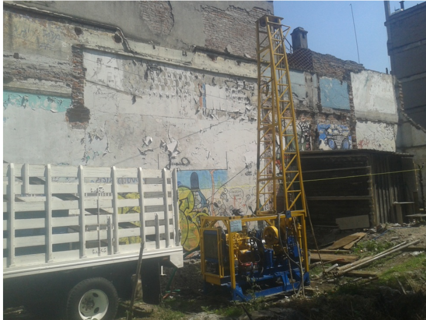
EQUIPO DE PERFORACIÓN EMPLEADO
