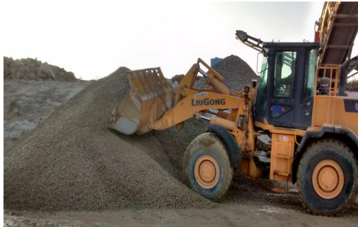
Figura 4.3.1.4 Mezclado de material para base hidráulica.
