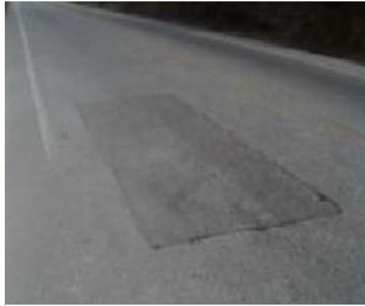
Figura 2.5.1.21 Reparación de la estructura del pavimento.
