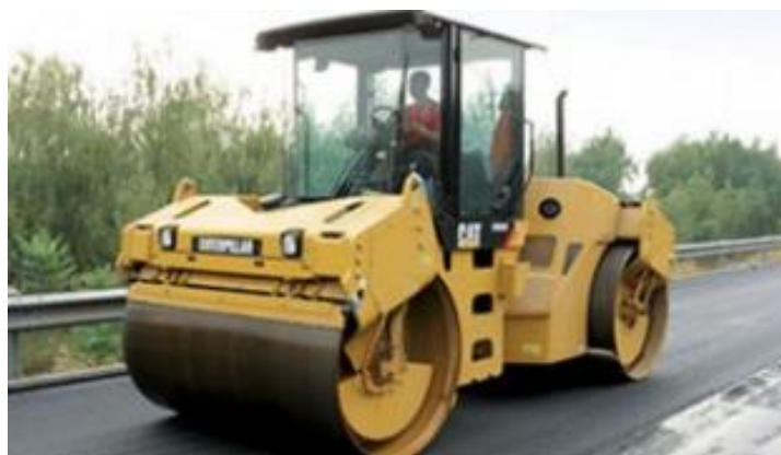
Figura 4.3.4.4 Compactación del sello con compactador metálico.
