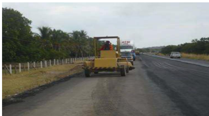
Figura 4.3.4.2 Barrido de la carpeta de concreto asfáltico para el tendido de sello premezclado del tipo 3-E.
