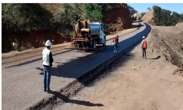
Figura 4.3.2.4 Realizando el bacheo con aspersores manuales.
