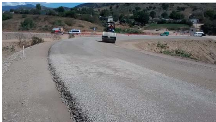
Figura 4.3.1.12 Compactación de base hidráulica en curva.
