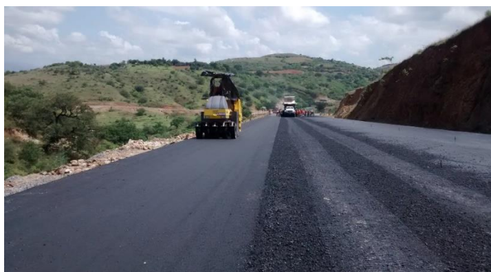
Figura 4.3.3.4 Compactación de carpeta asfáltica con neumáticos.
