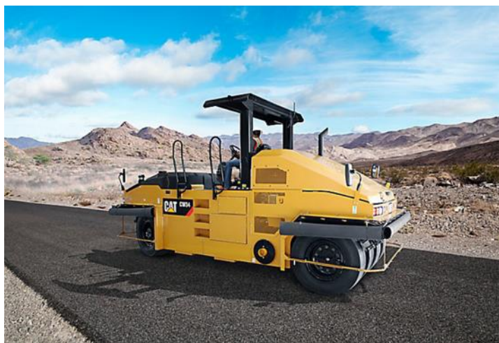
Figura 4.3.4.5 Compactación de sello con compactador neumático.
