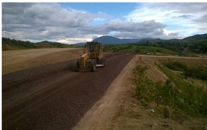
Figura 4.3.1.13 Motoconformadora.
