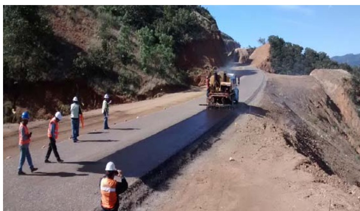
Figura 4.3.2.3 Tendido de riego de impregnación con petrolizadora.
