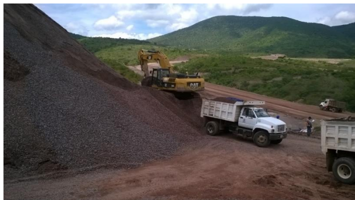
Figura 4.3.1.5 Llenado de camiones desde el banco de materiales.
