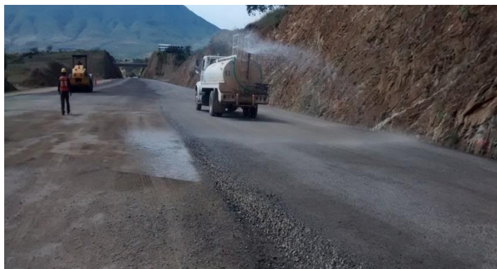
Figura 4.3.2.2 Humectación e hidratación de la superficie de base hidráulica antes de iniciar con el riego de impregnación.
