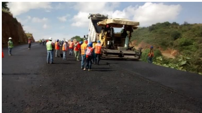
Figura 4.3.3.1 Colocación de carpeta asfáltica con pavimentadora sobre orugas.
