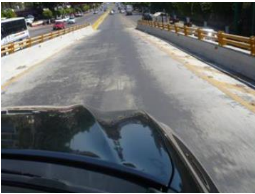
Figura 2.5.1.7 Pulido de superficie.
