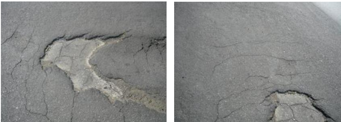
Figura 2.5.1.17 Grietas parabólicas.
