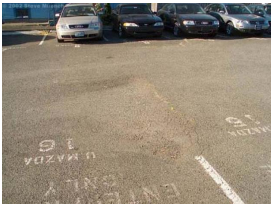
Figura 1.5.2.2 Elevaciones y hundimientos.
