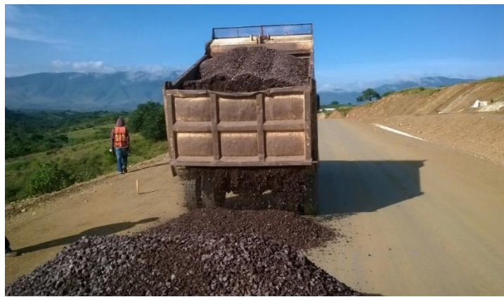
Figura 4.3.1.7 Arribo y vaciado de los camiones con el material para base hidráulica.
