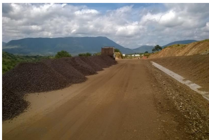
Figura 4.3.1.8 Vaciado del material para base hidráulica a lo largo de un tramo.
