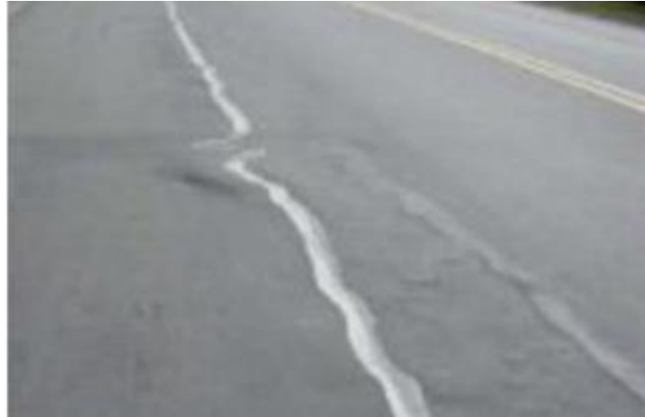
Figura 2.5.1.10 Ondulaciones transversales.
