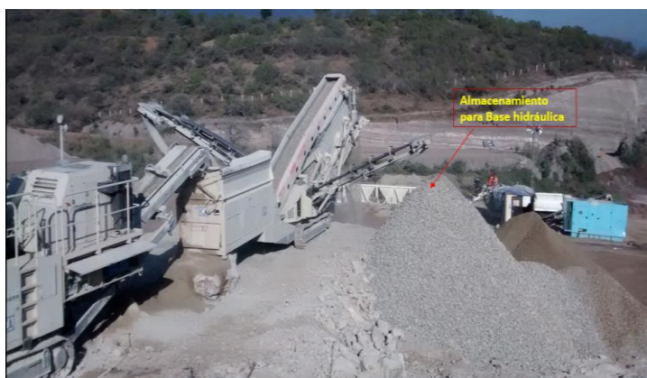
Figura 4.3.1.3 Tren completo de trituración de material para base hidráulica.
