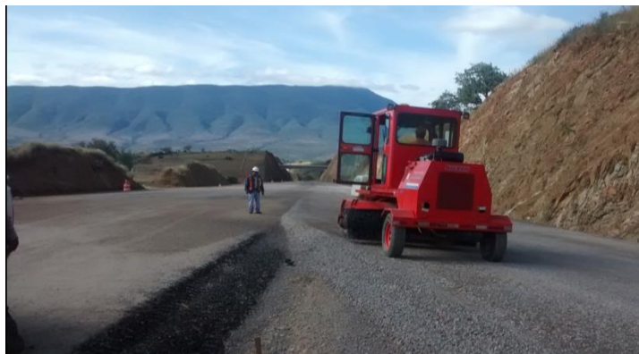
Figura 4.3.2.1 Superficie de base hidráulica limpia de polvo y materiales extraños.
