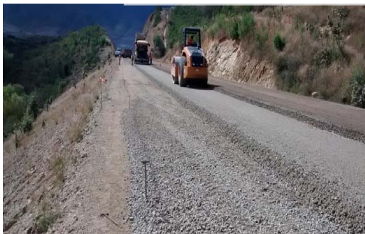
Figura 4.3.1.11 Compactación de base hidráulica.
