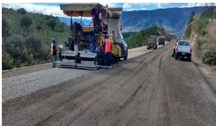
Figura 4.3.1.10 Tendido de material para base hidráulica con pavimentadora sobre orugas.
