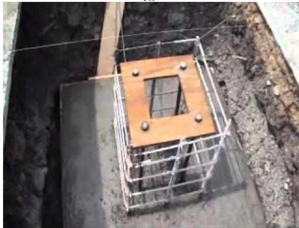
La zapata aislada se emplean para recibir las cargas de una columna (apoyo aislado). Por lo general son de sección cuadrada o también pueden ser rectangulares, y su trabajo es la flexión es en dos direcciones, llevando, por lo tanto refuerzo de acero espaciado uniformemente en ambos sentidos.
