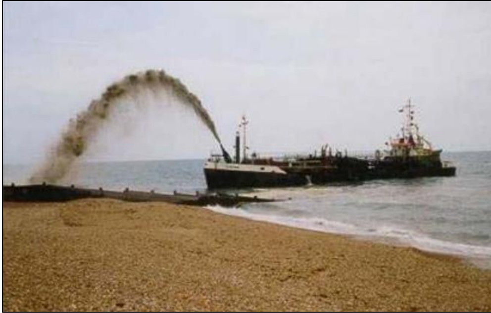
Figura 3.2 Relleno de playa por bombeo de arena
