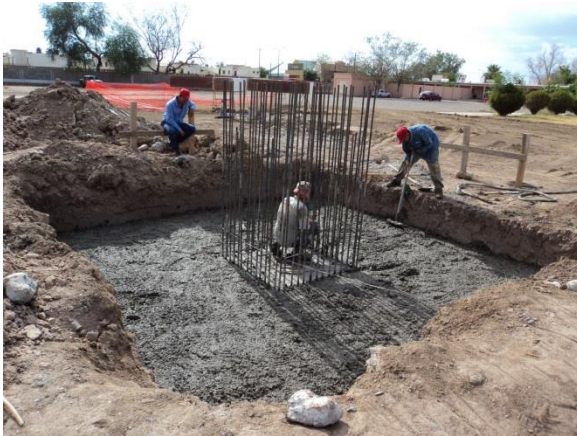
Zapata de concreto reforzado.
