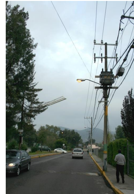
E2 Av. Coporo (vialidad sur)
