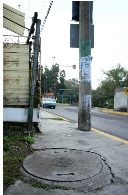
E1 Av. Coporo (vialidad sur)
