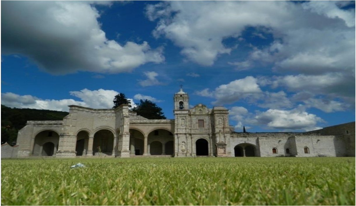
Imagen 21 Capilla abierta, templo y claustro. Vista desde atrio
