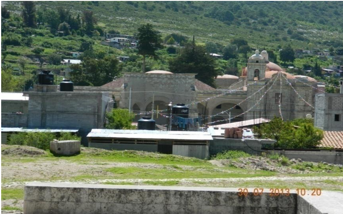
Imagen 11 Vista desde la Casa de la Cacica hacia la Capilla Abierta
