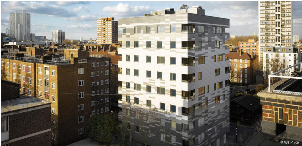
Ilustración 45. Edificio de varios niveles " Stadthaus, Murray Grove". Fuente: http://www.klhuk.com/portfolio/residential/stadthaus
