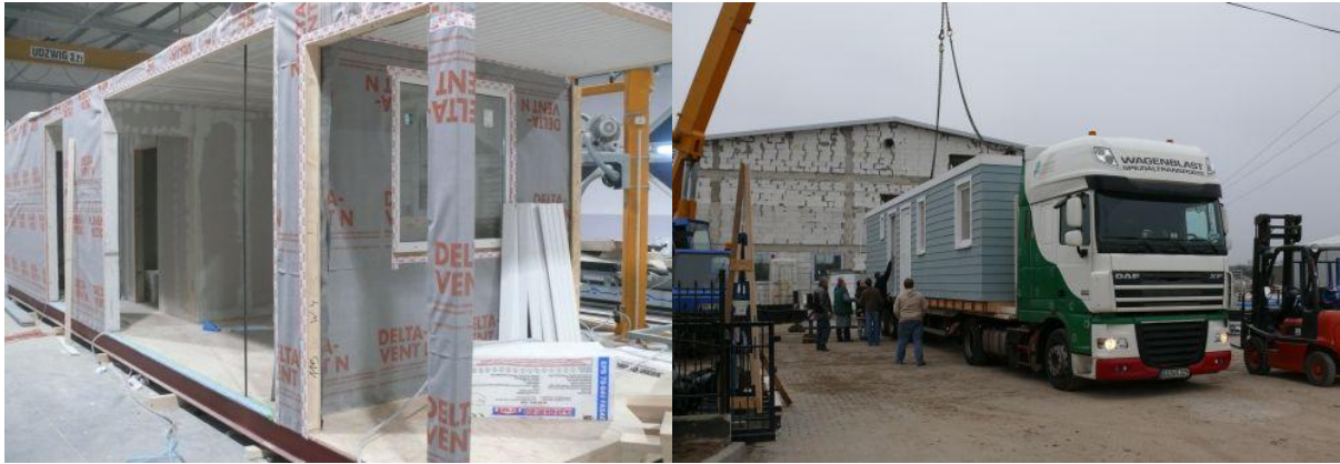
Ilustración 34. Prefabricación y transporte al sitio: Sistema Domy Modulowe Kopahaus. Fuente: (kopahaus, 2013)
