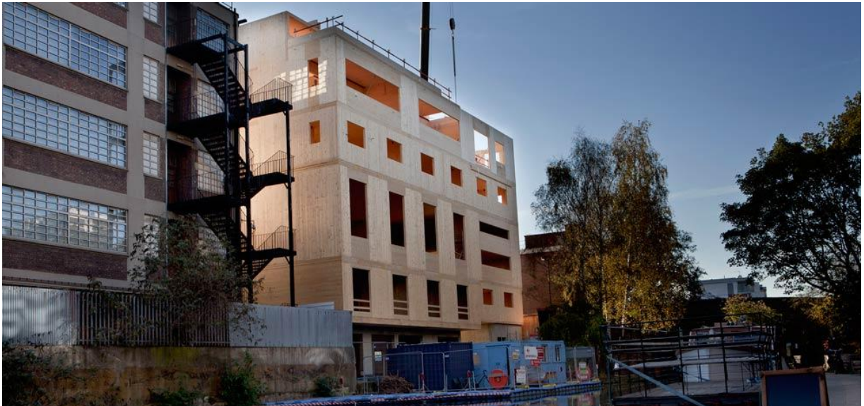
Ilustración 47. Edificio de 5 niveles en proceso de construcción. Fuente: http://www.klhuk.com/portfolio/education/lauriston-primary-school .
