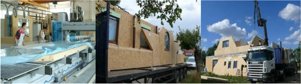
Ilustración 40. Prefabricación y ensamblaje. Fuente: (kopahaus, 2013)
