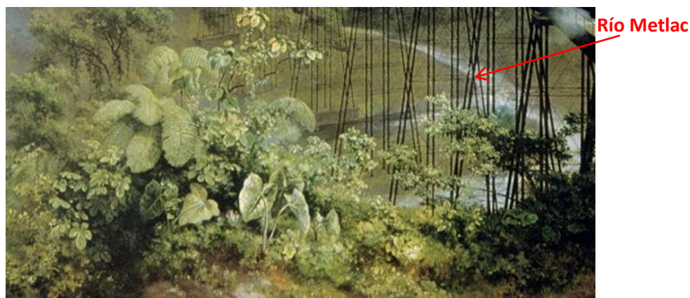
50. Detalle Puente curvo del Ferrocarril Mexicano en la cañada de Metlac , 1881
