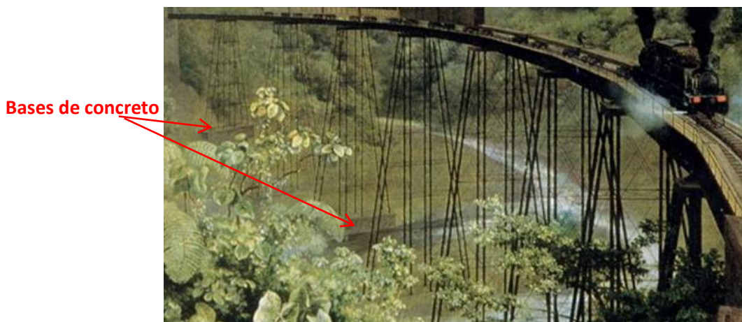
46. Detalle Puente curvo del Ferrocarril Mexicano en la cañada de Metlac , 1881
