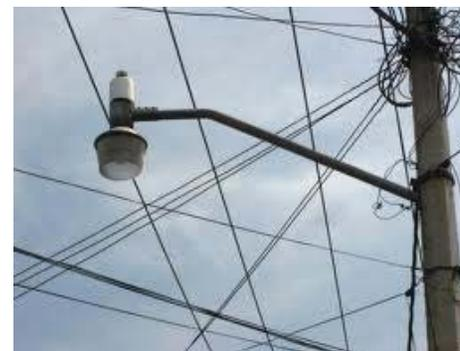
El mantenimiento de este sistema se hace cotidianamente y consiste en rehabilitación de luminarias, cambio de balastos, reposición de foto celdas, pintura de postes, reparación de postes corroídos, liberación y limpieza de luminarias. Adicionalmente se tiene un programa de suministro y colocación de luminarias nuevas tipo O.V. 15 en áreas o zonas oscuras a fin de mantener la cobertura del alumbrado público a su máxima capacidad posible.
