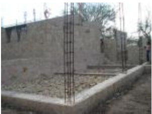
Armado de castillo
