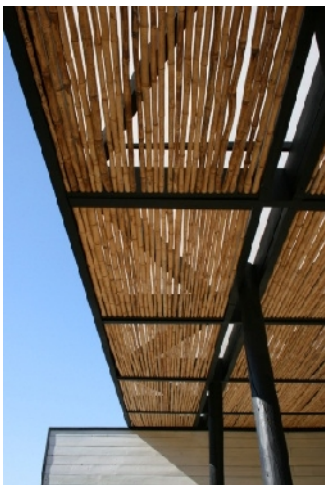
Estructura portante de acero para cubierta de carrizo
