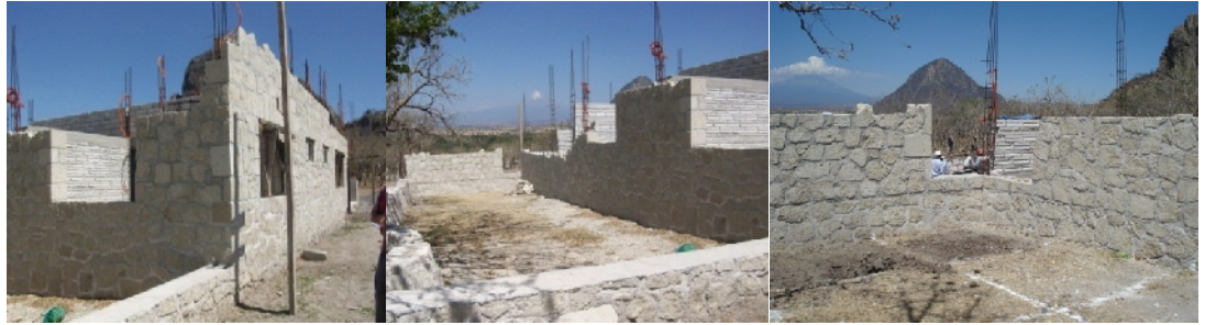
Fotografía de la primera y segunda visita a obra y su avance constructivo. Febrero 2012
