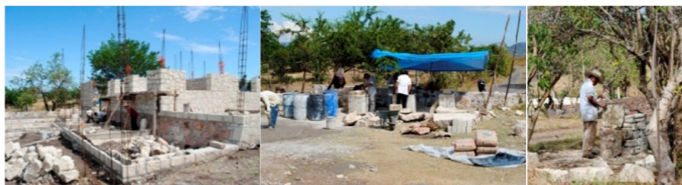
FOTOGRAFÍAS DE PROCESO DE TRAZO Y DESPLANTE DE CIMENTACIÓN.
