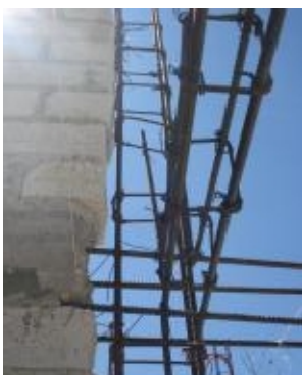
Armado de castillo y cerramiento
