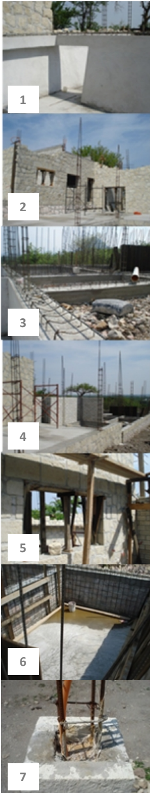
Foto 1: Zapatas; Foto 2: Muros de habitaciones; Foto 3: Armado de trabe de liga y castillos; Foto 4: Muro de mampostería; Foto 5: Cimbras para vano de ventana; Foto 6: Colado de Cisterna; Foto 7: Desplante de castillo
