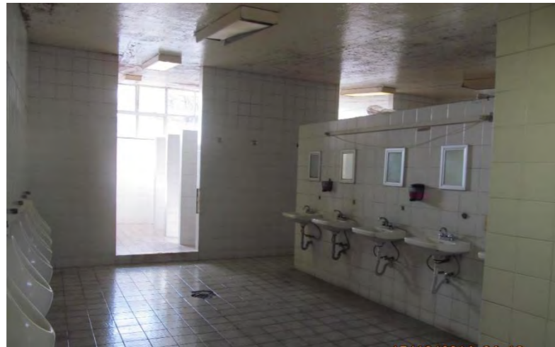
Vista interior de los servicios sanitarios.
