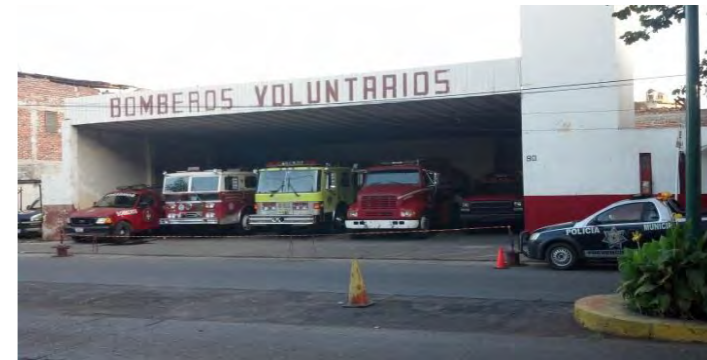
Antigua Base. Vista desde calle principal de su ubicación
