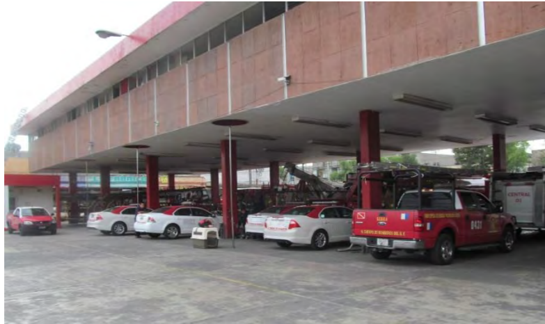
Vista exterior del área de estacionamiento.
