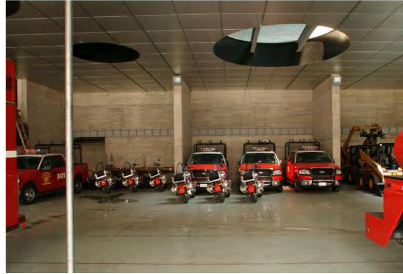
Vista interior del estacionamiento vehicular.
