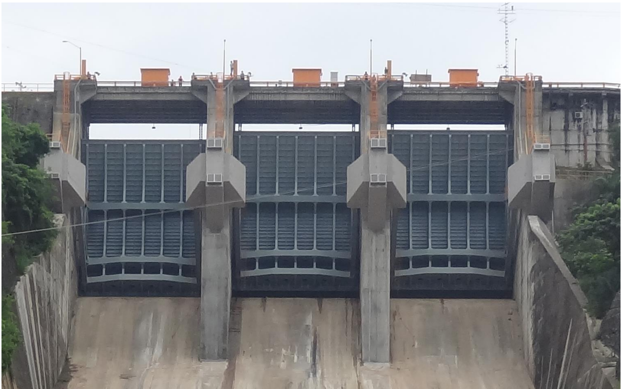
Figura 3.9 Reforzamiento de Compuertas y vigas testeras
