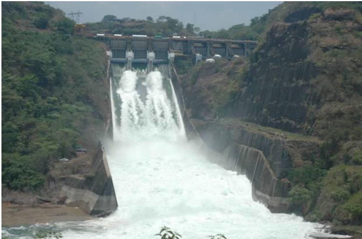
Figura 1.2 Operación del vertedor de servicio, mayo 2008. Q=1\ 797\ \text{m}^3/\text{s} (Camacho, 2008)
