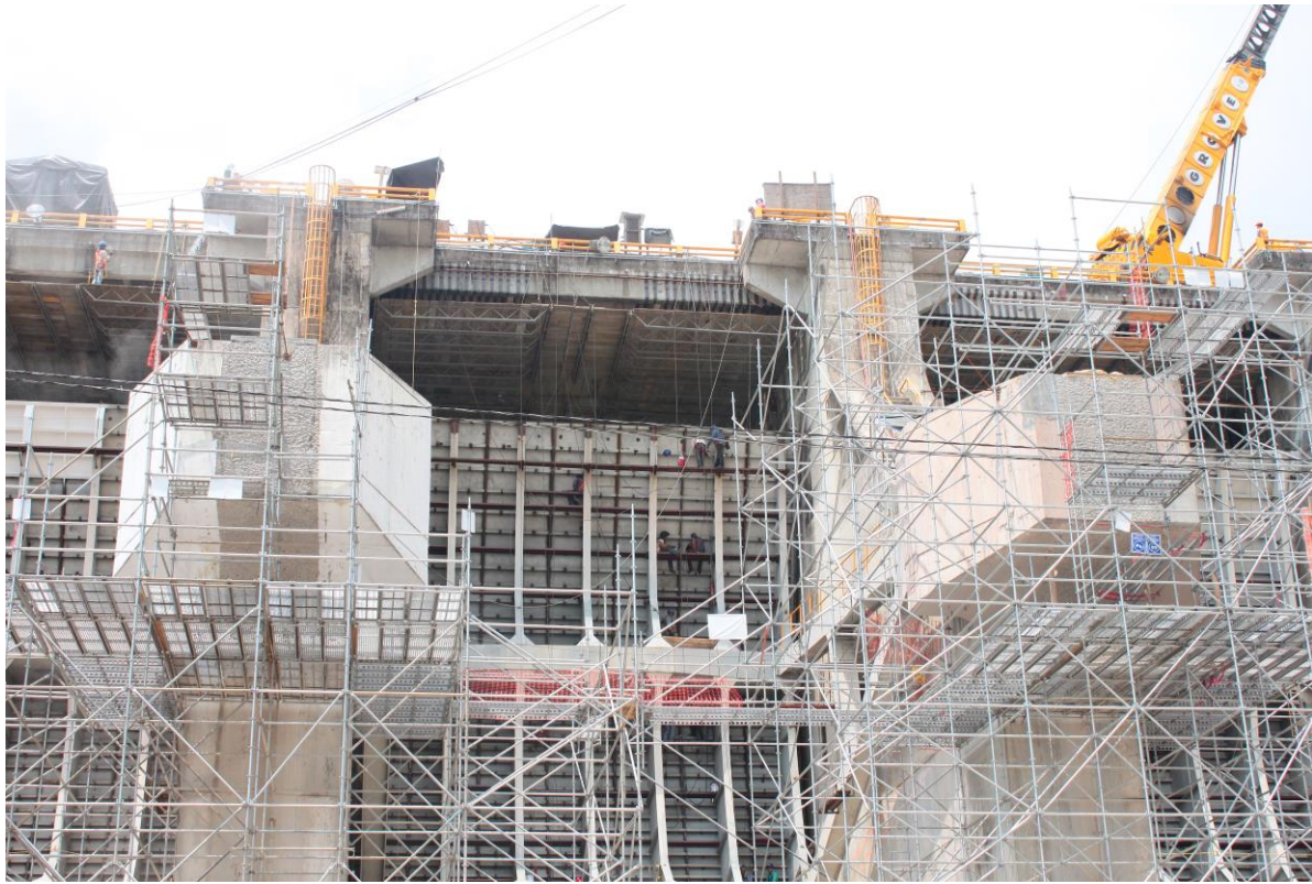
Figura 3.23 Reforzamiento de compuertas y vigas testeras
