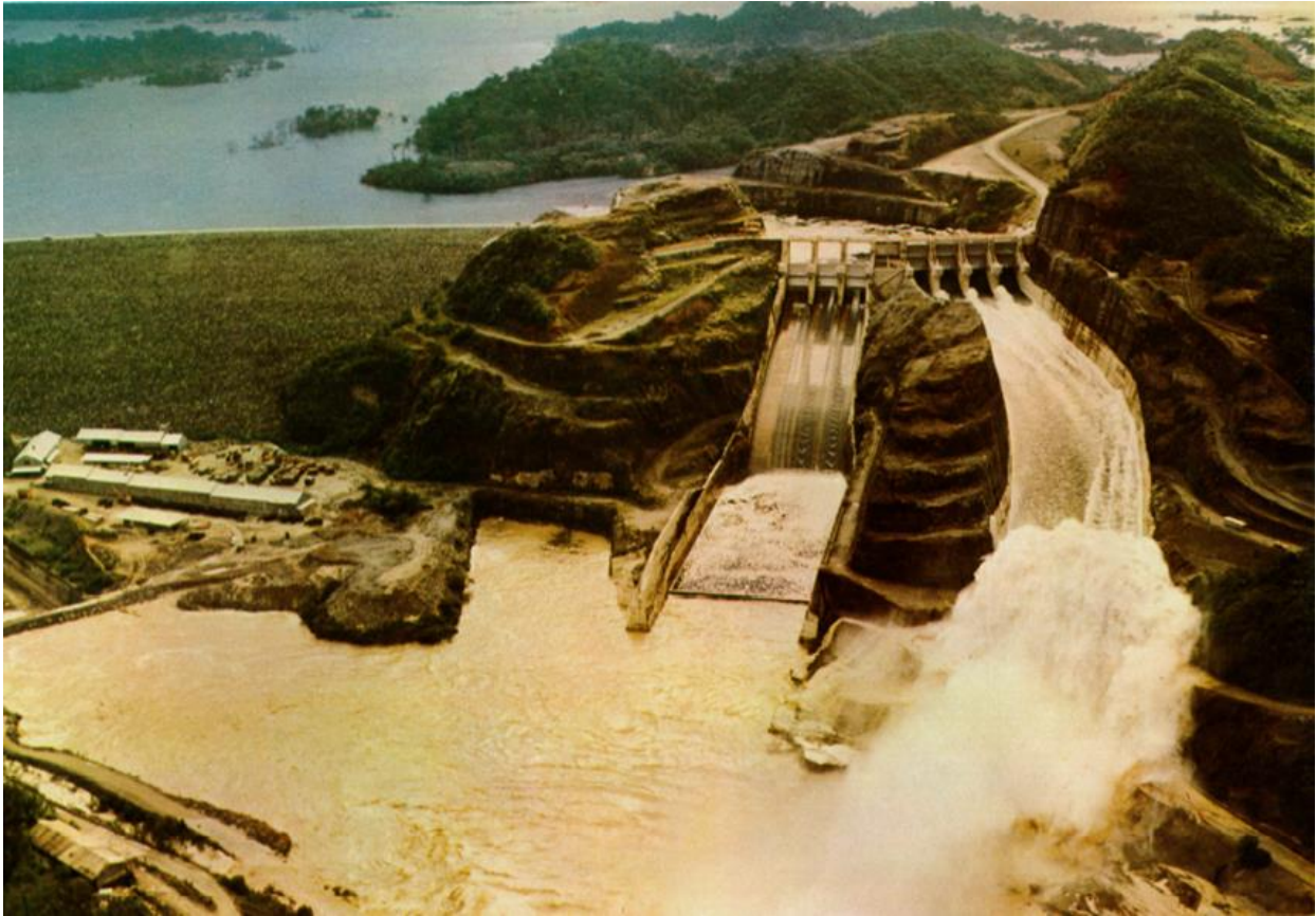
Figura 1.3 Operación del vertedor de emergencia, Q=2\ 800\ m^3/s (SRH, 1976)
