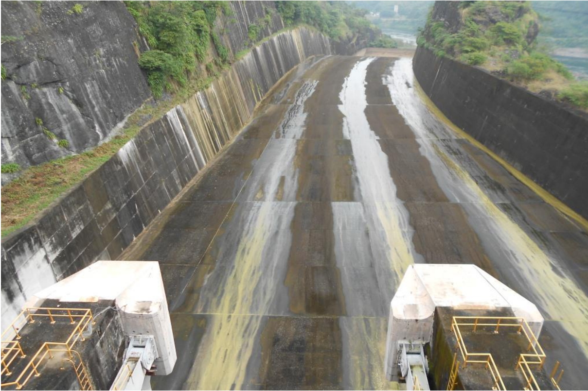
Figura 3.16 Vertedor de emergencia original
