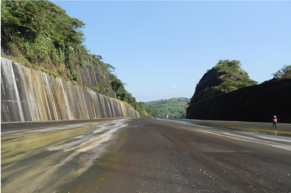
Figura 3.19 Canal de descarga del vertedor de emergencia
