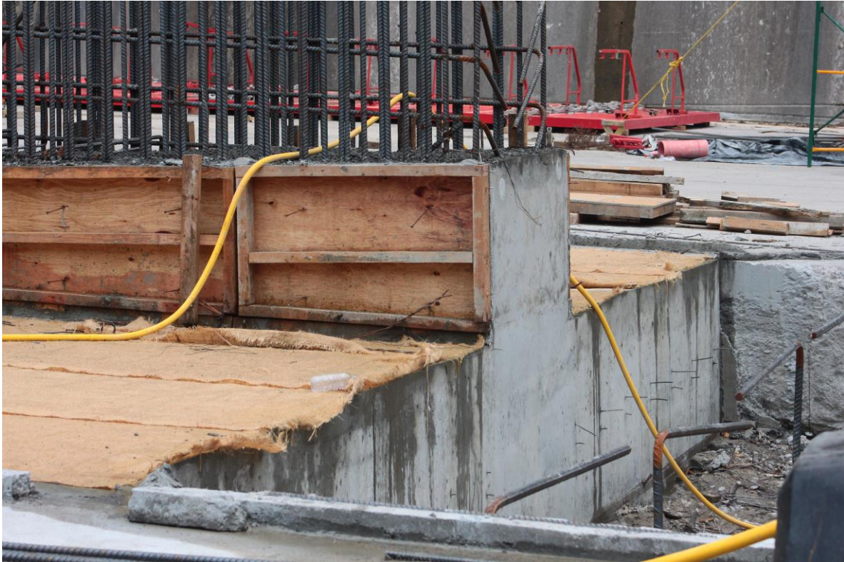
Figura 3.14 Cimentación del muro central
