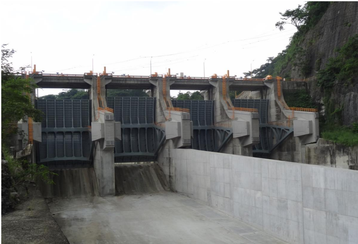
Figura 3.26 Vigas testeras reforzadas en el vertedor de emergencia
