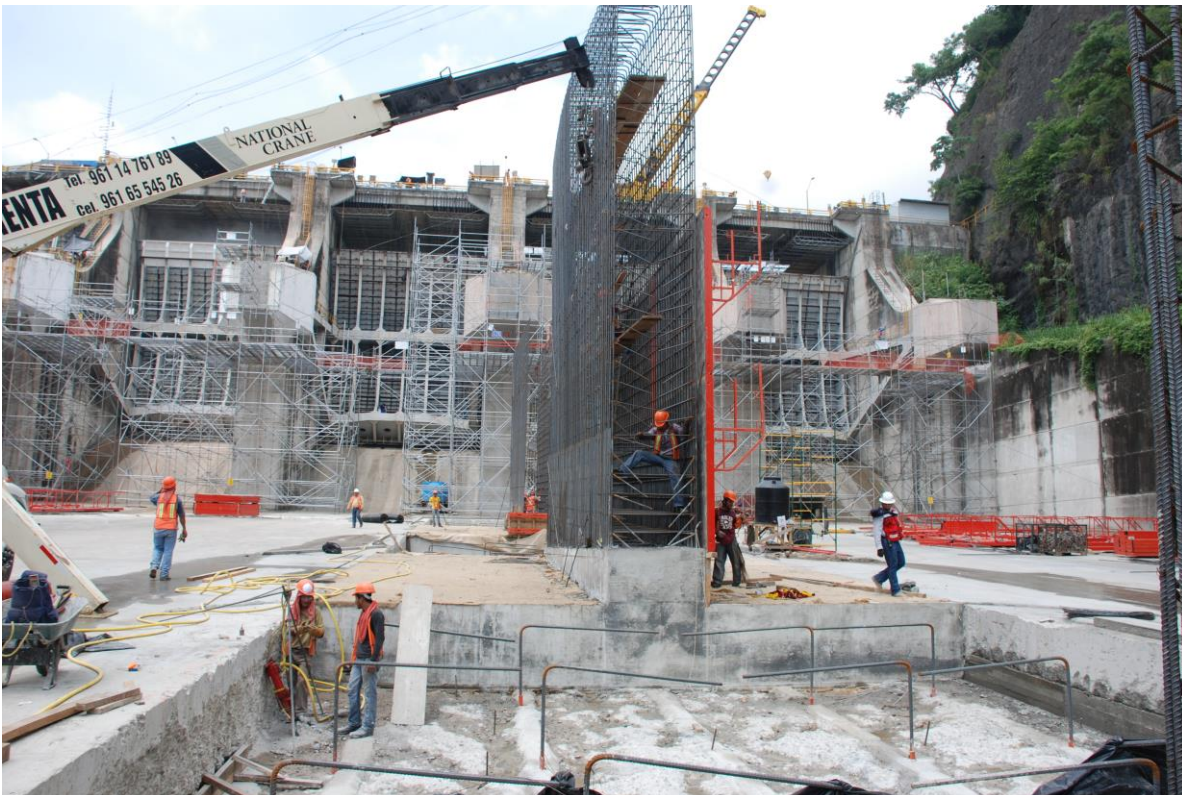
Figura 3.15 Habilitado del acero para muro central
