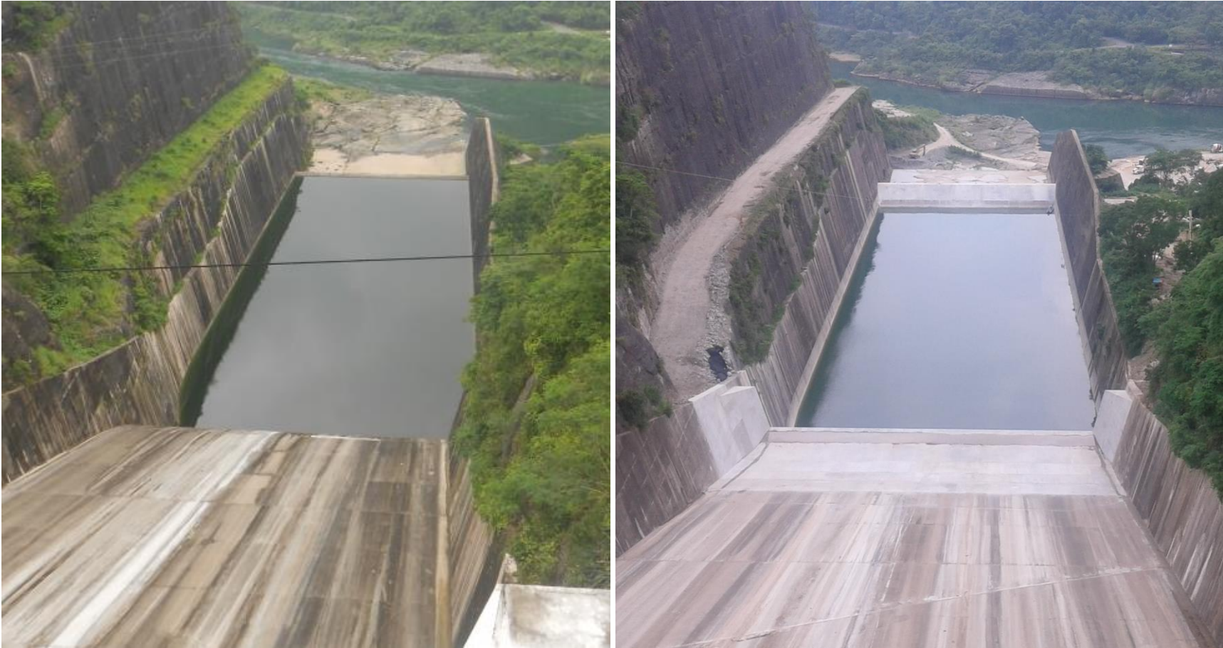
Figura 3.6 Vista del salto de esquí, deflectores y sobreelevación
