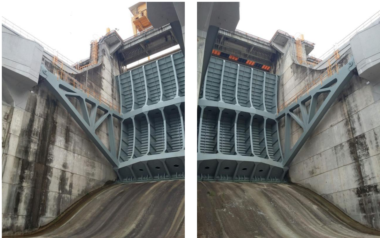
Figura 3.24 Compuertas del vertedor de emergencia reforzadas
