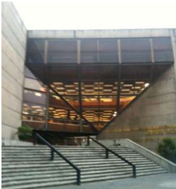
Fotografía: elaboración propia
