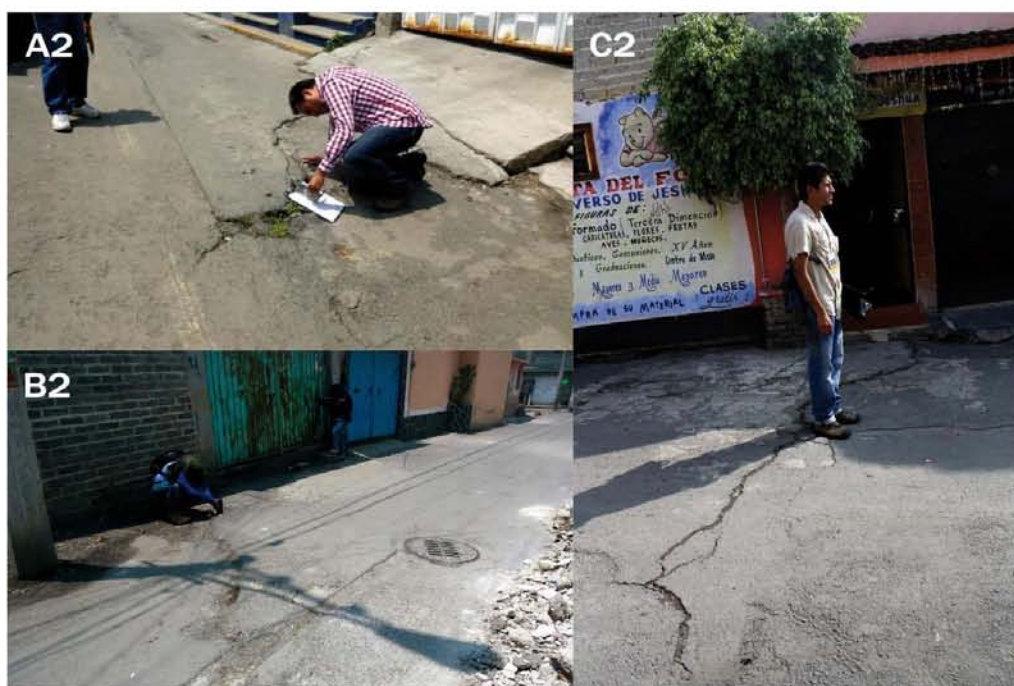
Figura 18. Fotografías A2, B2 y C2 (Ubicadas en el mapa de la Figura 11. Mapa de peligro por fracturas). Imágenes obtenidas en calles consecutivas a dos manzanas afectadas por una fractura.
