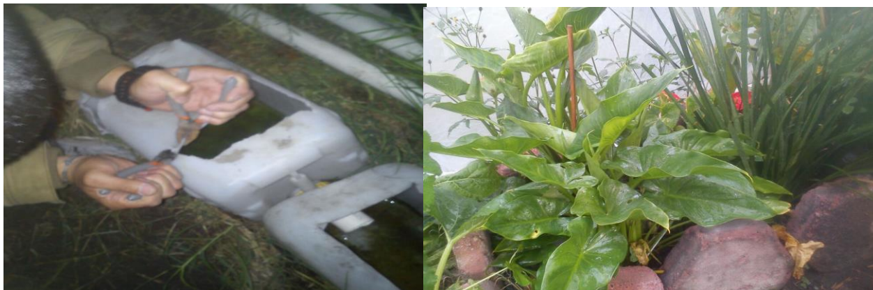
Figura 14. Construcción del humedal artificial dentro del invernadero
