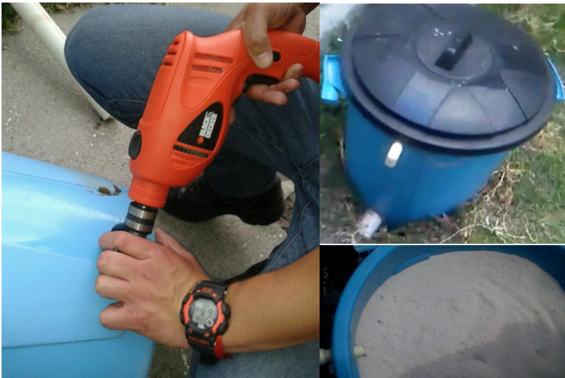
Figura 12. Construcción del filtro de arenas y gravas (Anexo 4)
