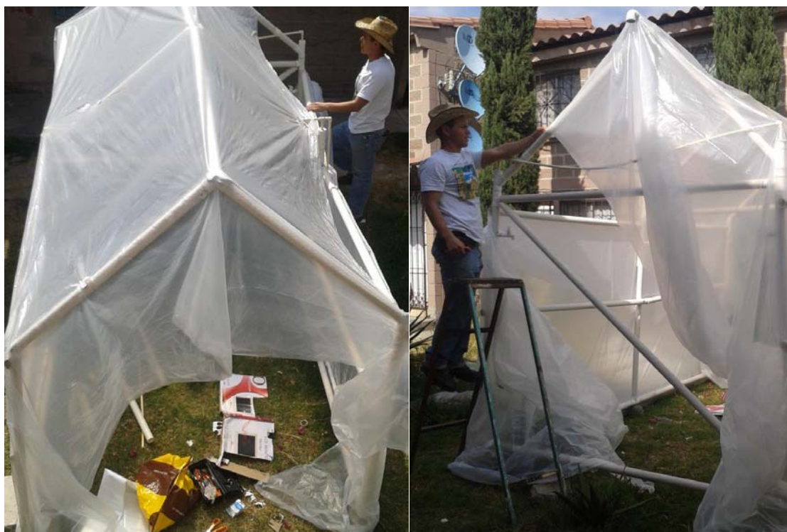
Figura 10. Primera fase de la construcción del invernadero rústico
