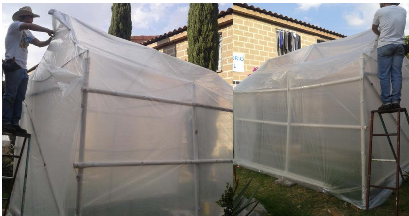
Figura 11. Segunda fase de la construcción del invernadero rústico
