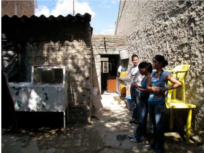
Fotografía 26 Vivienda en proceso de consolidación
