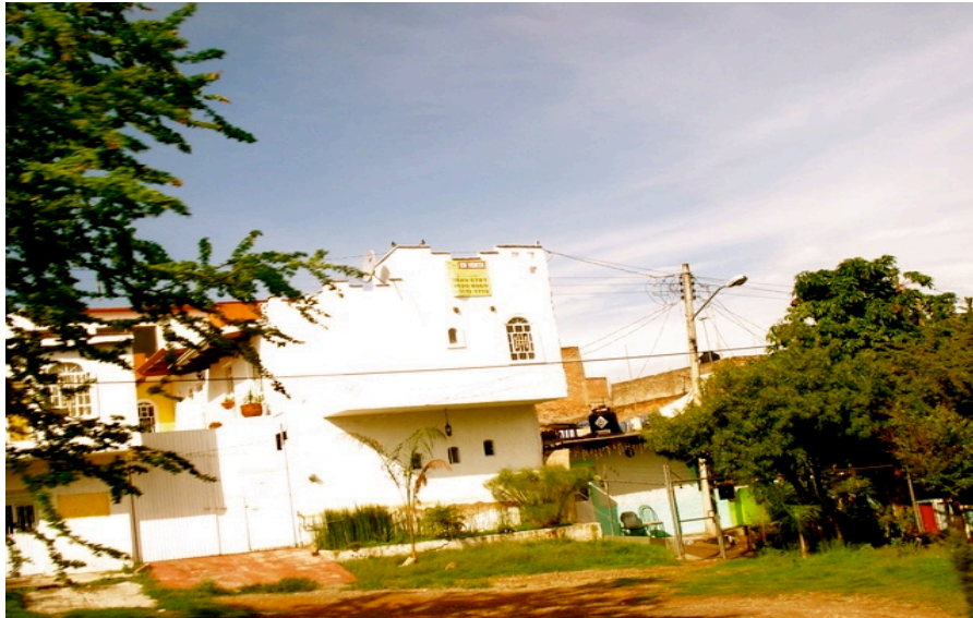
Fotografía 2. Viviendas ubicadas en el área de restricción del periférico Manuel Gómez Morín. Colonia Rancho Nuevo
