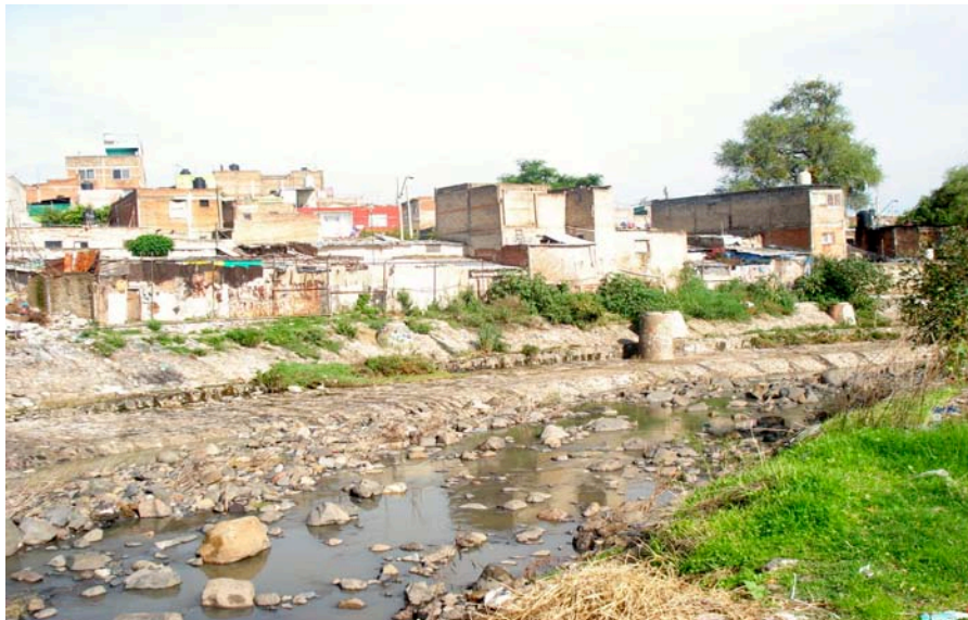
Fotografía 1. Viviendas vulnerables ubicadas cerca del Río San Juan de Dios. Colonia Rancho Nuevo
