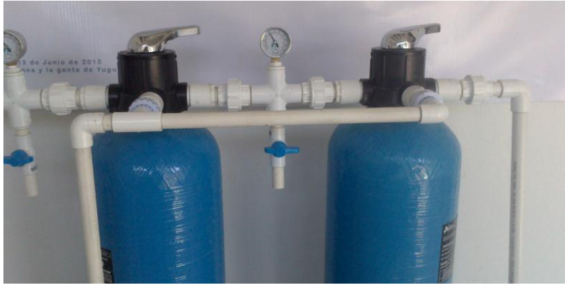
Figura 29. Sistemas de filtrado de primer paso (Imagen propia)
