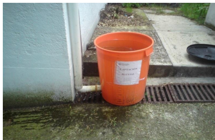
Figura 12. Sistema piloto de captación (Gallardo 2011)
