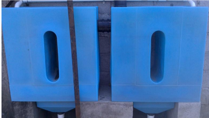
Figura 27. Tlaloques colocados por Isla Urbana (Imagen propia)
