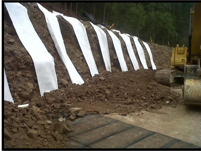
Imagen IV.9. Instalación del sistema de drenaje
