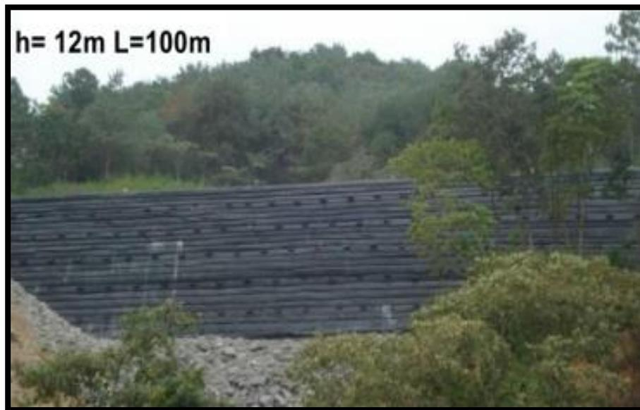
Imagen II.4. Aplicación de geosintéticos en muros mecánicamente estabilizados
