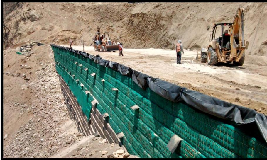
Imagen II.18. Construcción de muro geosintético
