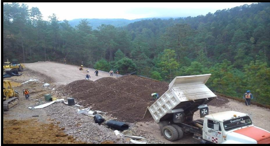
Imagen IV.18. Colocación de capas subsiguientes
