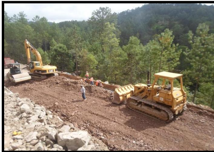
Imagen IV.16. Colocación y tendido de material térreo en capas
