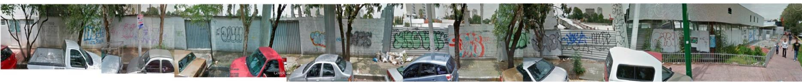
Fachada sur- Xontepec
