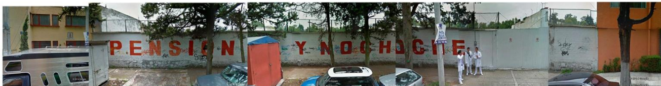
Fachada norte- Sillón de Mendoza
