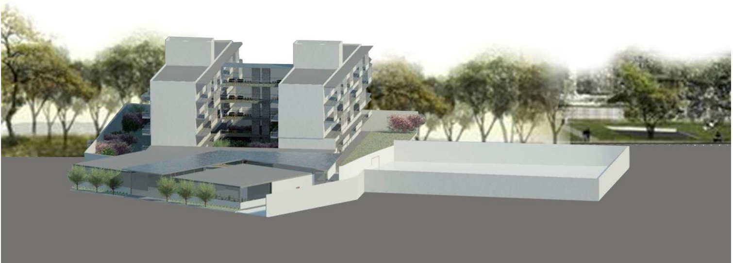
Vista fachada Noreste
