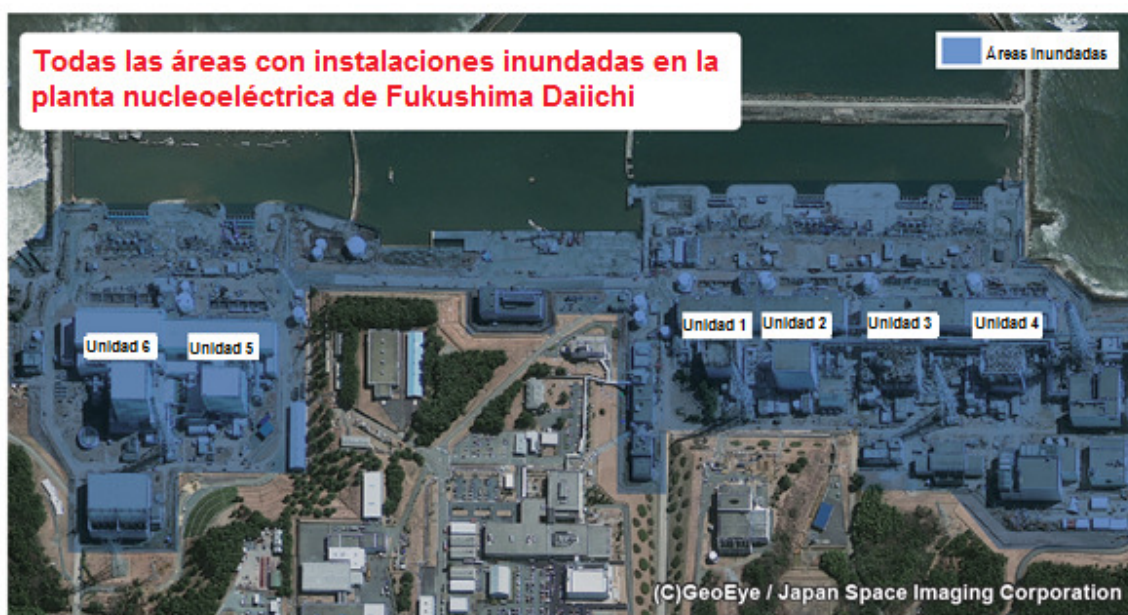
Figura 4-2 Instalaciones de Fukushima Daiichi después de la llegada del tsunami, 19 de Marzo de 2011 [16]
